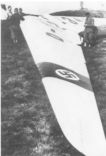
Планер Но.III отличался увеличенным удлинением крыла и измененной системой управления.
