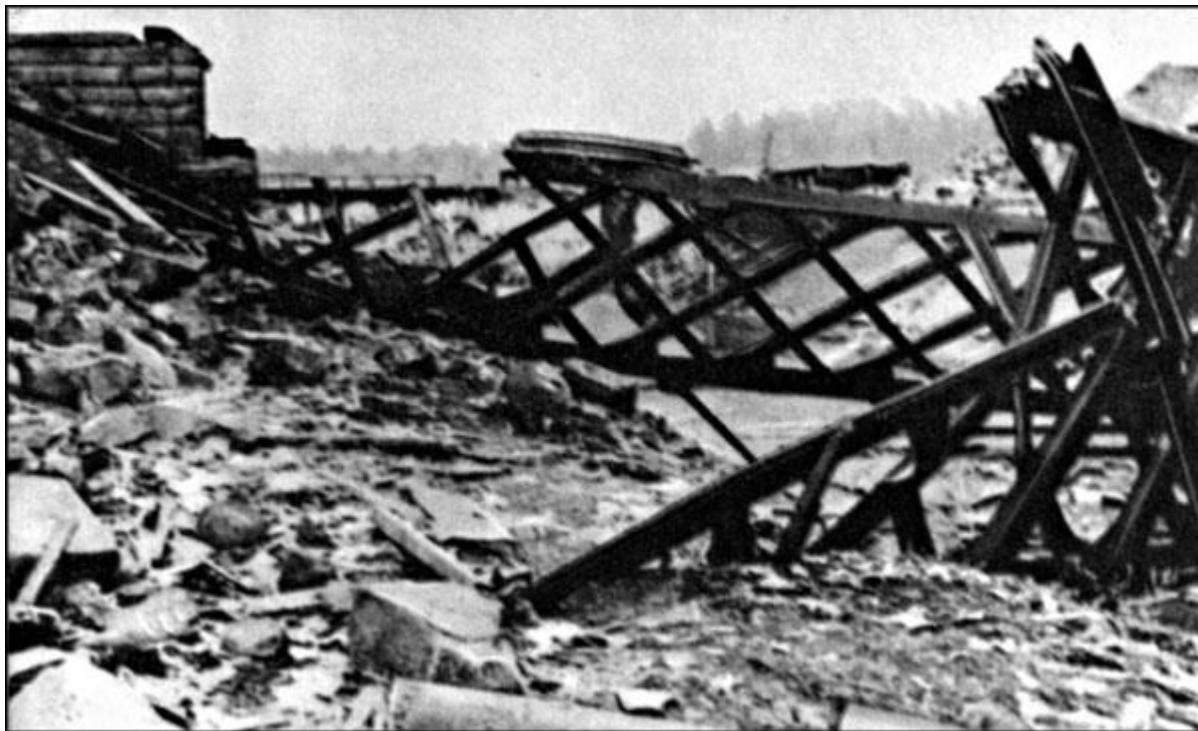
Взорванный оперативной группой мост. Еще одна вражеская коммуникация нарушена
