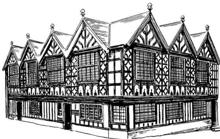
Рисунок 10 – Честер, дворец Стенли-пэлис (1591 г.). «Черно-белый» полуфахверк раннего елизаветинского стиля, 7 поперечных фронтонов, типичные закругленные раскосы и большие, сильно члененные окна
