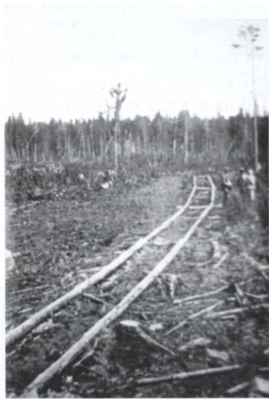
Круглолежневая дорога для вывозки леса летом (использовалась Добрянским ЛПХ в 1943–1948 гг.)
