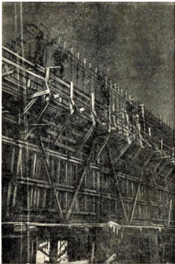
Установка арматуры для бетонирования низовых пал шлюза, февраль 1954 г.
