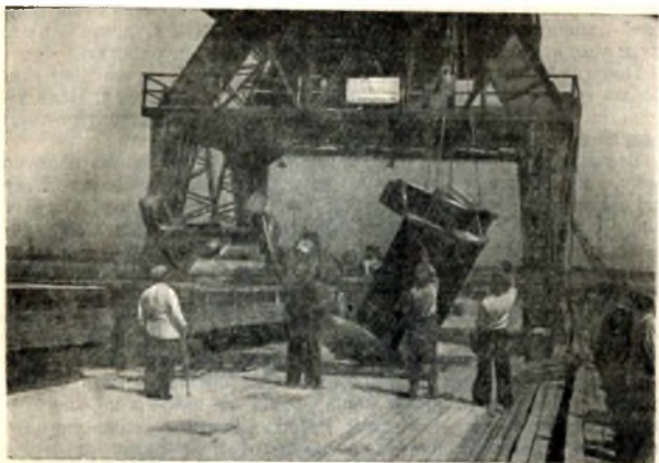
Подача частей статора для монтажа, июнь 1953 г.
