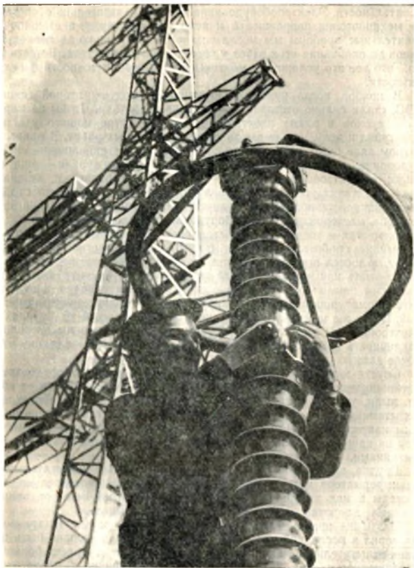
Монтаж высоковольтных изоляторов.
