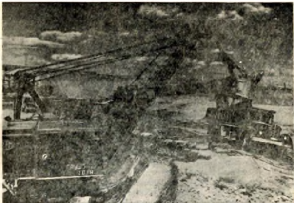
Отсыпка низовой перемычки котлована второй очереди водосливной ГЭС, август 1954 г.
