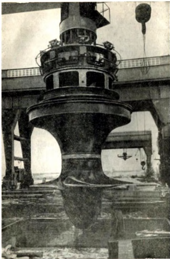
Подъем из монтажной мастерской укрупненного узла агрегата и установка его на ряж, март 1955 г.
