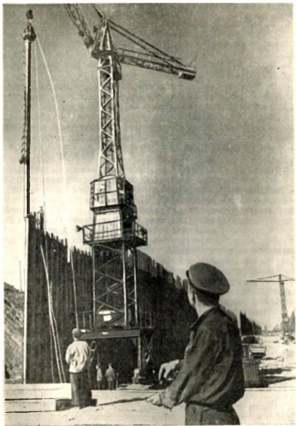
Погружение шпунта в стенки шлюза с помощью электровибратора, июнь 1953 г.
