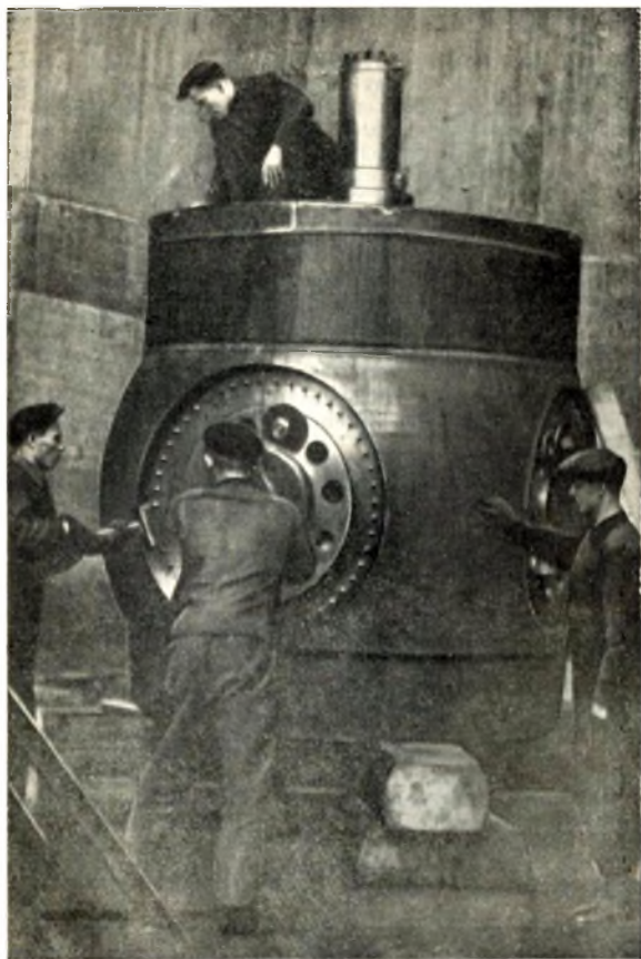
Монтаж рабочего колеса турбины.
