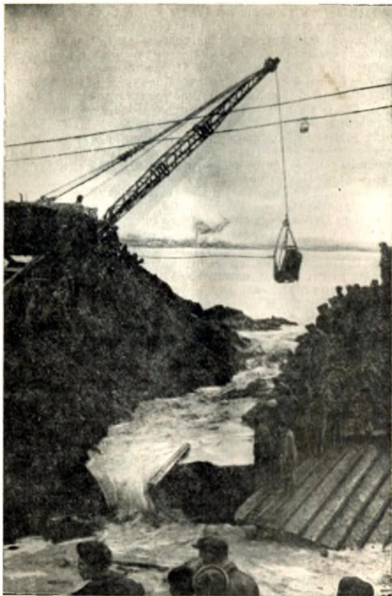
Экскаватор делает проход в низовой перемычке для затопления котлована первой очереди водосливной ГЭС, 10 октября 1953 г.
