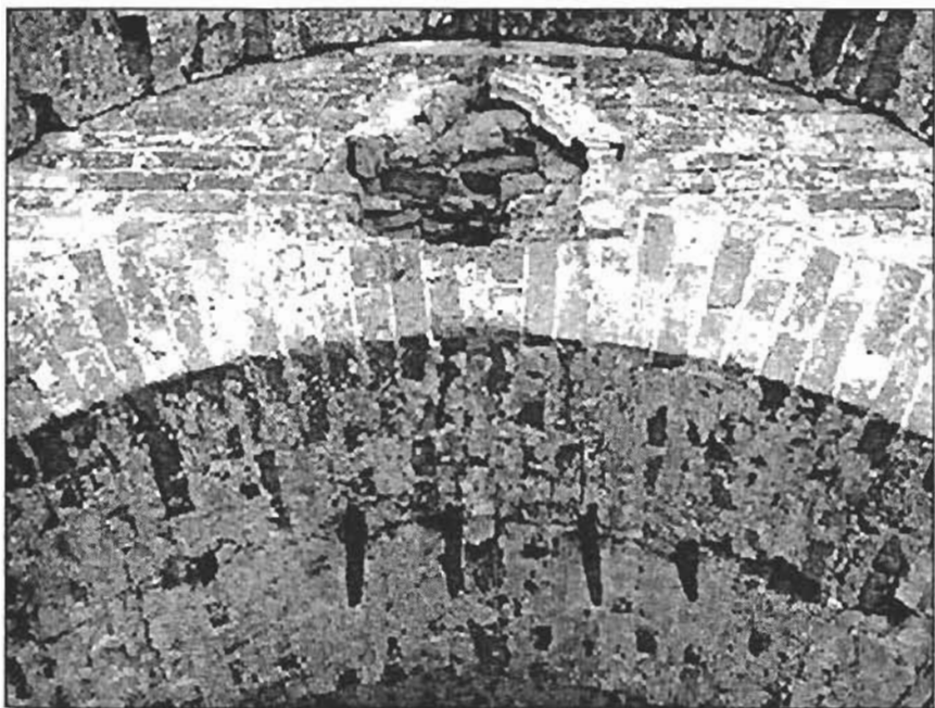
Герса, замурованная в кладке воротного проема
