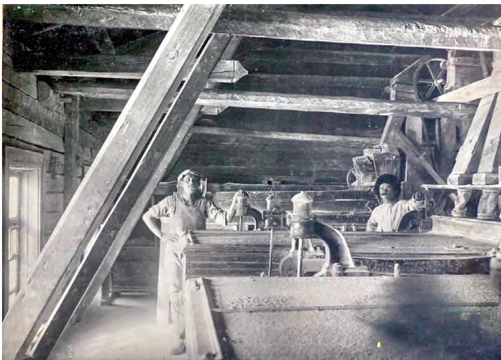
Рассевной отдел вальцево-механической мельницы купца Каримова. Пржевальск. 1914 г.
