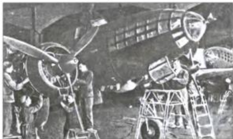
Сборка бомбардировщика Ил-4
