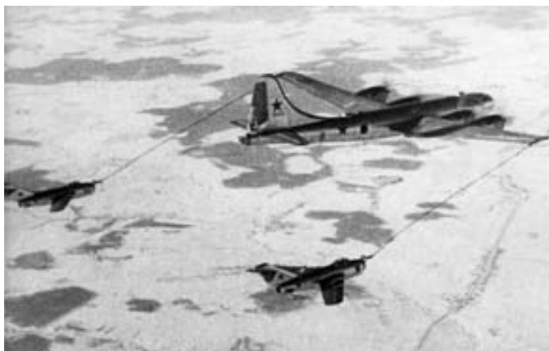
Система буксировки истребителей «Бурлаки»
