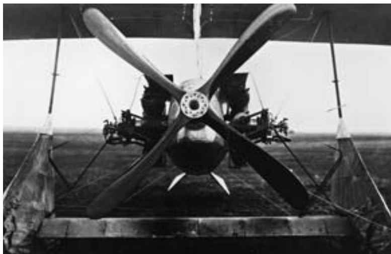
Самолет Коанде с двумя «Гномами», работающими на один пропеллер
