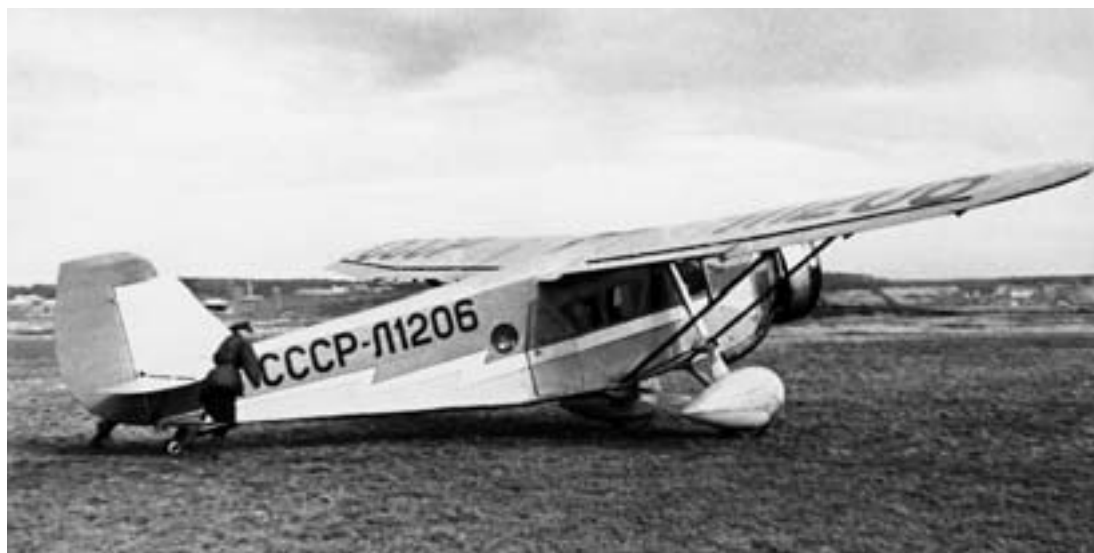
«Сталь-3» – самолет из «нержавейки»
