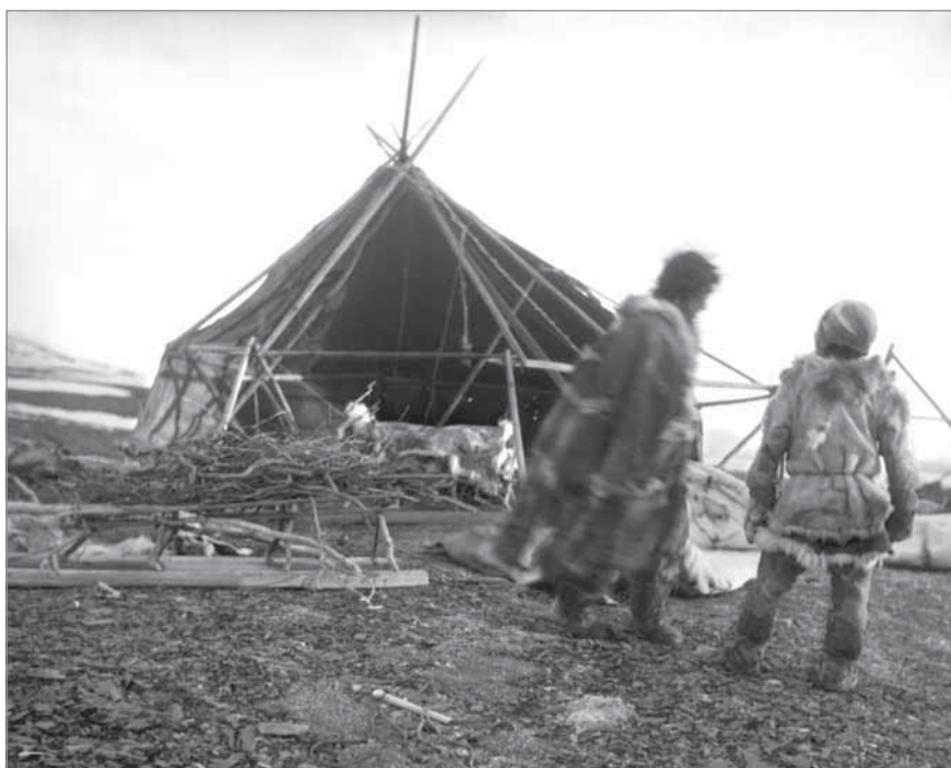
Рис. 89. Недостроенная яранга с натянутой половиной покрытия (рэтэм).
