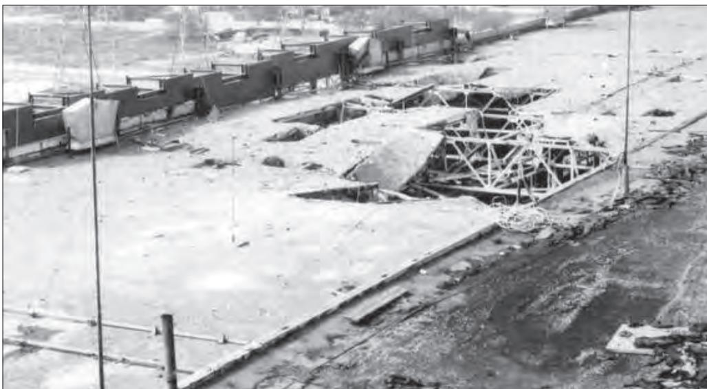
Разрушенная кровля на машзале 4-го блока
