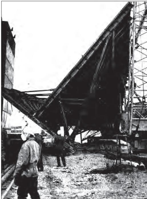
Вторая каскадная стенка опрокинулась
