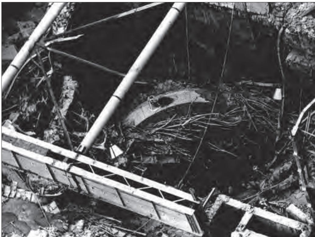
«Самолет» установлен, и внизу видна перевернутая крышка реактора «Елена»
