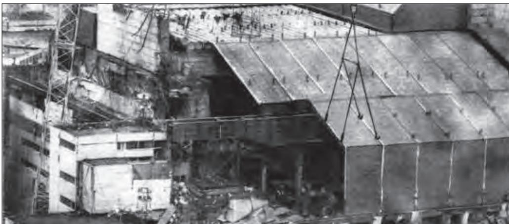
Монтаж «ключек» со стороны деаэрационной этажерки. Видна опора 51 под балку «Мамонт» и опирание балки «Осьминог» на разрушенные перекрытия
