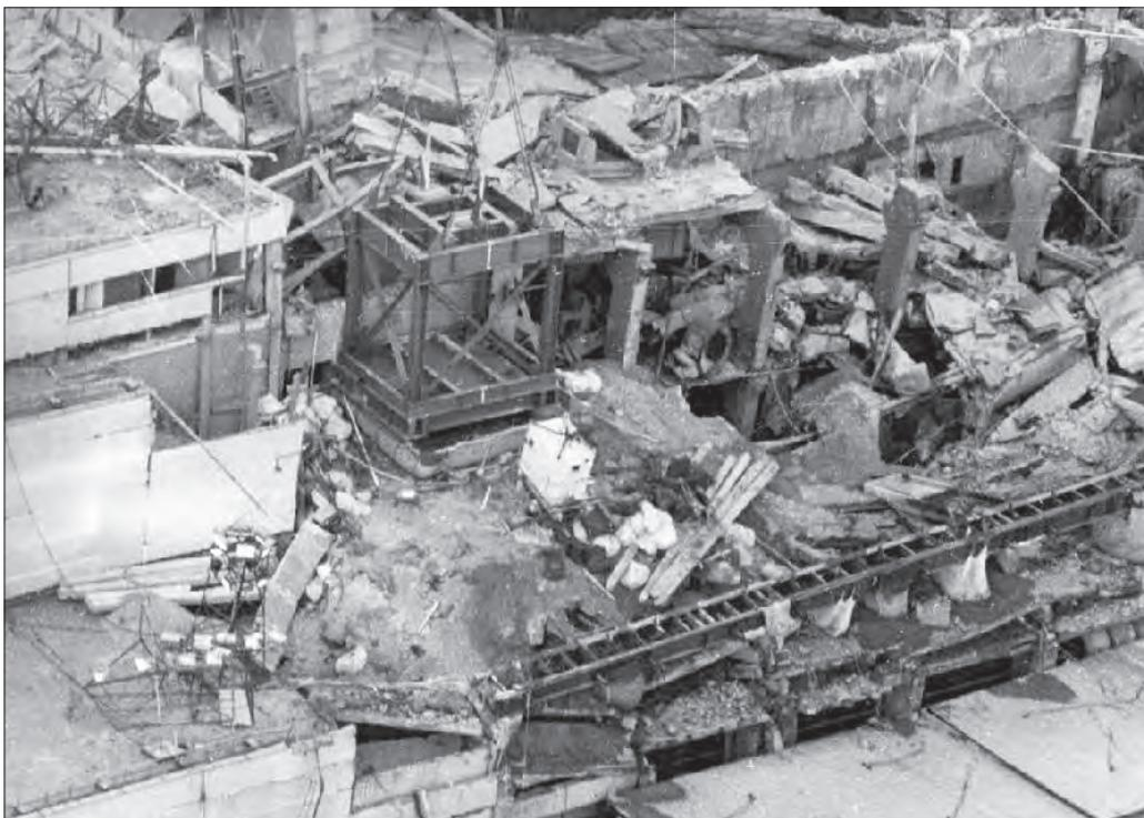
Металлическая опора под названием «табуретка» (весом 87 т) установлена в проектное положение. Рядом стоит «Батискаф», а внизу балка «Осьминог» (длиной 92 м)
