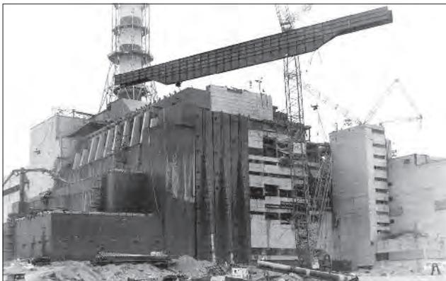
Подъем балки «Мамонт» на пределе грузоподъемности
