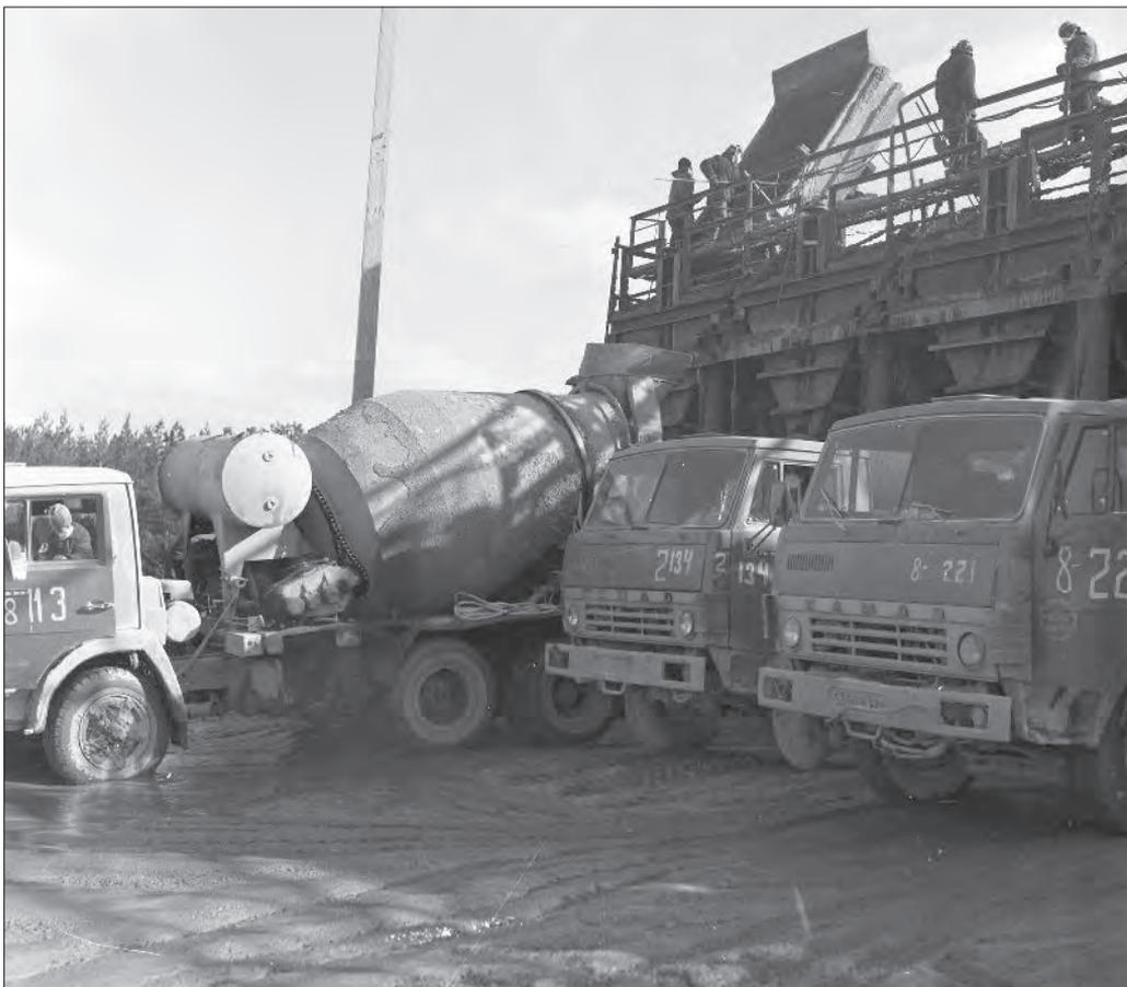
День и ночь бесперебойно работал район перегрузки бетона из чистого транспорта в «грязные» миксеры
