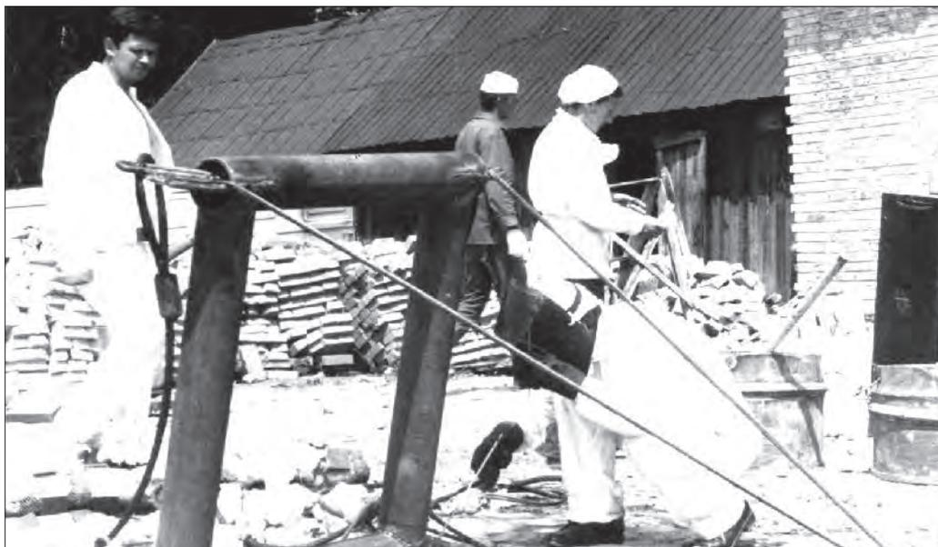
Подготовка клеевых захватов на «Сельхозтехнике» для заброса на кровлю 3-го блока. Июль 1986 г.
