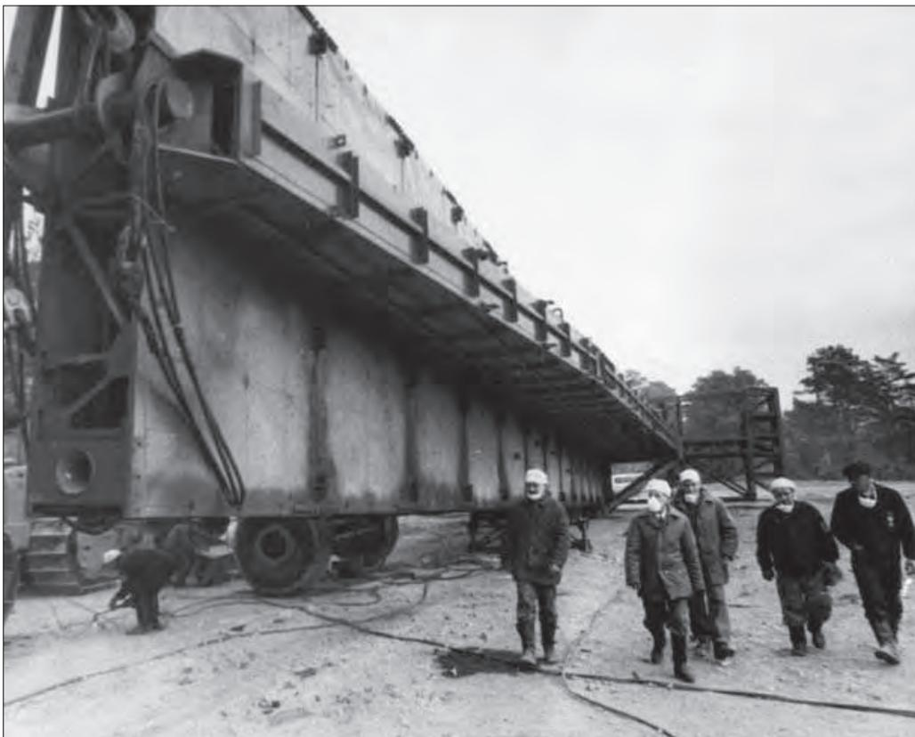
Контрфорсный блок длиной 45 м и весом 90 т готов к транспортировке
