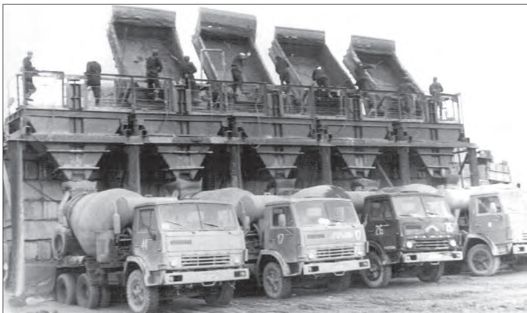
Военнослужащие на перегрузке бетона из «чистых» машин в «грязные»
