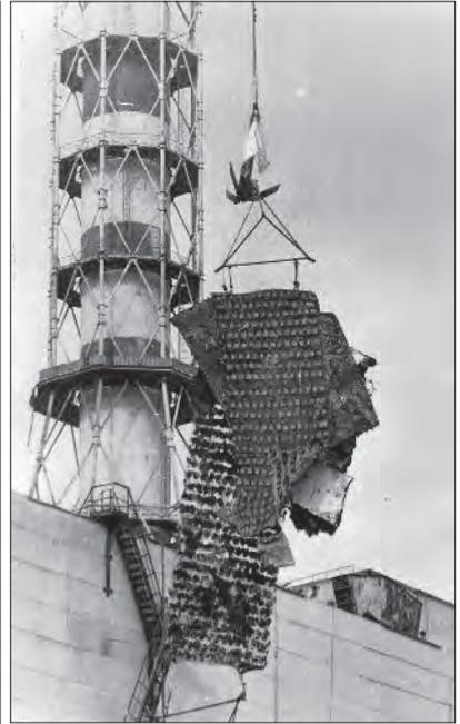
Съем клеевого захвата с кровли
