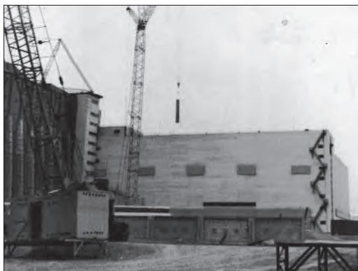
С помощью крана «Демага» «промокашку» укладывали на очищаемую поверхность
