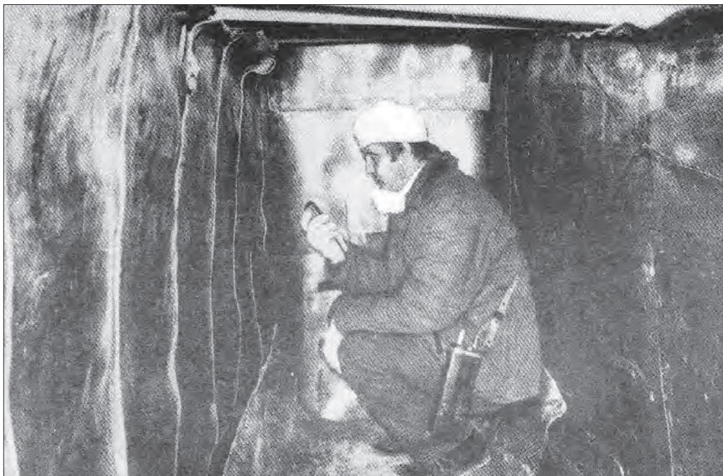
Наблюдательный пункт на 3-м энергоблоке. Стены облицованы свинцом
