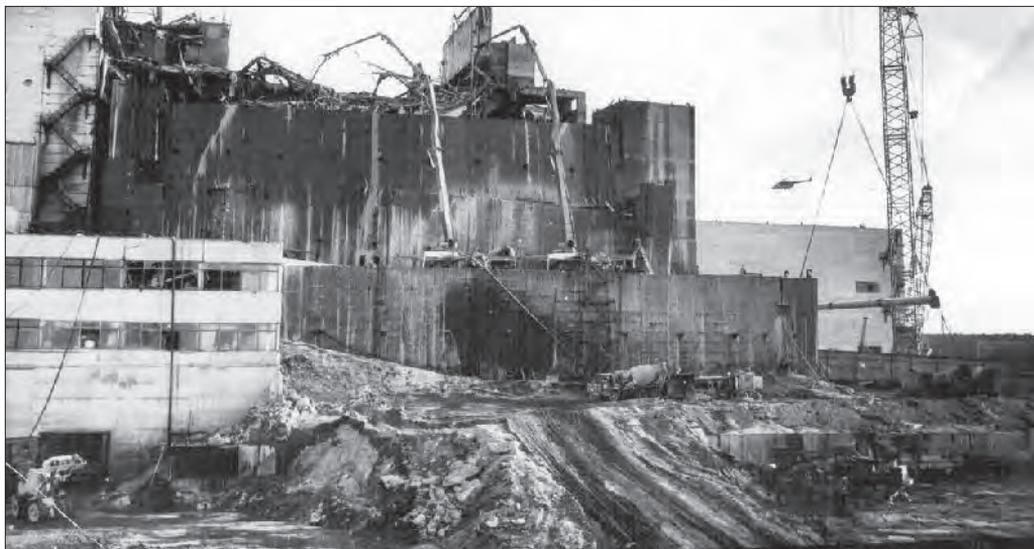
Заливка бетоном каскадной стенки
