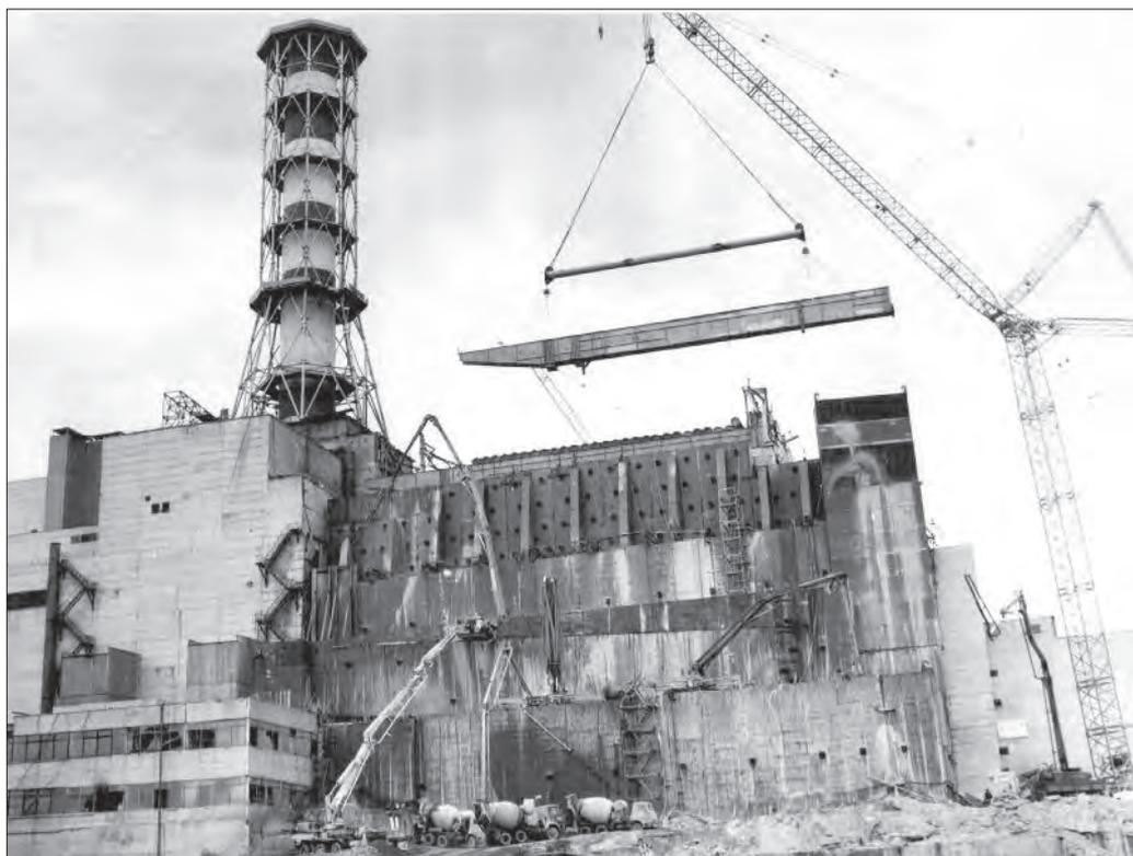
Перекачка бетона с использованием двух бетононасосов за 4-ю каскадную стенку
