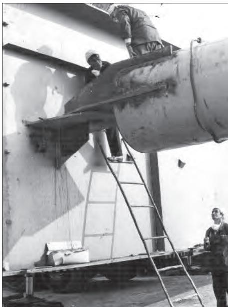
Приварка распорок на балке «Самолет»
