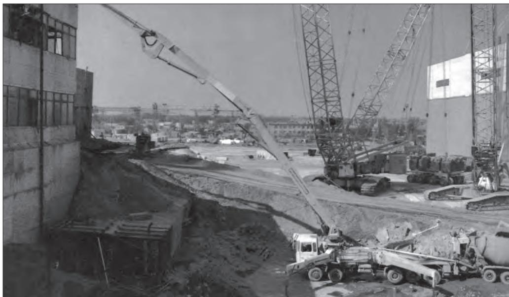
На переднем плане бетононасос
