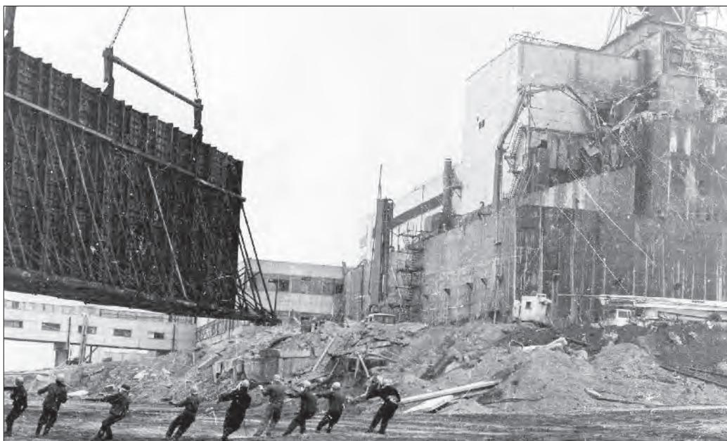
Чтобы установить в проектное положение третью каскадную стенку, требовалась помощь до 20 монтажников. Вес этой стенки больше 120 тонн
