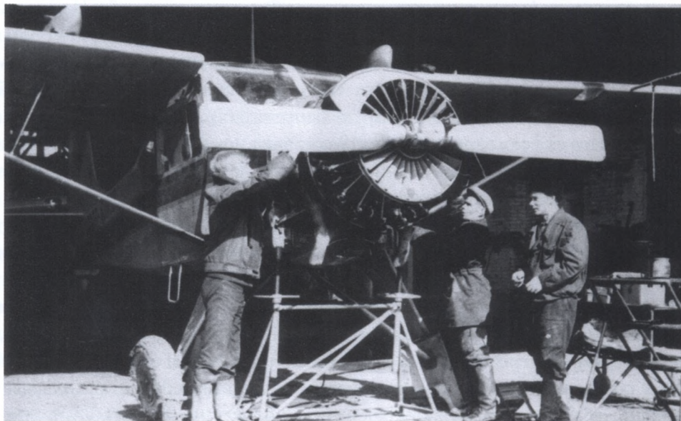
Обслуживание двигателя Як-12 могло проводиться в полевых условиях...
