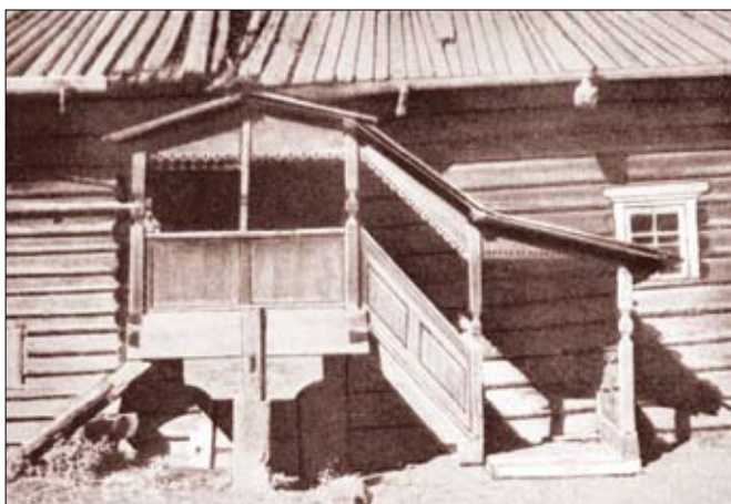
Деревня Придворово, Верхне-Тоемский район Архангельской области. Крыльцо избы на одном столбе. Фото Р. Фонвизина
