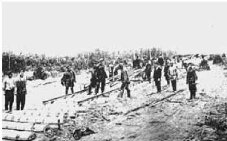
Укладка пути рабочими вручную
