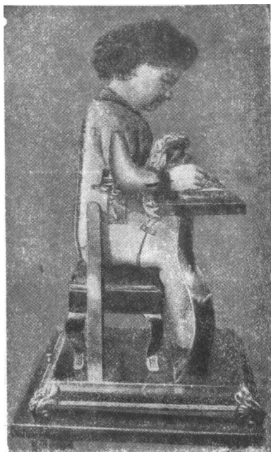
Механический писец. С куклы снята одежда, чтобы показать внешний вид устройства.
