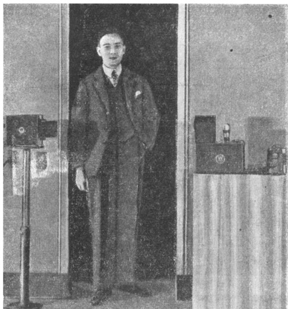
Ультрафиолетовый счетчик людей, входящих в помещение. Слева на подставке внутри ящика лампа, дающая ультрафиолетовые лучи, пучок которых перегораживает дверь и попадает в фотоэлемент справа.
