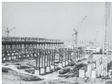
Монтаж конструкции сталепокатного цеха ММЗ, 1980-е гг.
