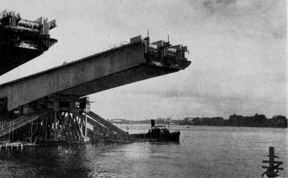
Строительство моста Александра Невского. Железобетонный блок — «птичка» подготовлен к перевозке.
