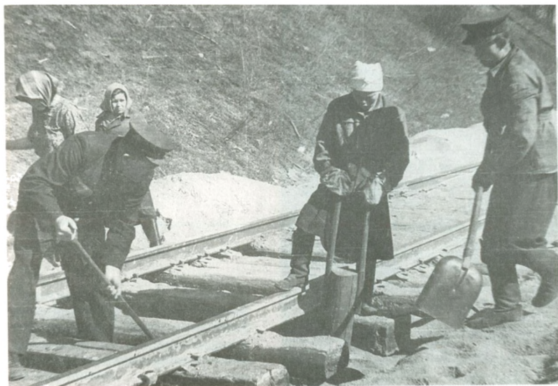
Для борьбы с пучинами земляного полотна в Пермской дистанции пути успешно применялся способ врезки асбестовых «подушек» и «рубашек».
