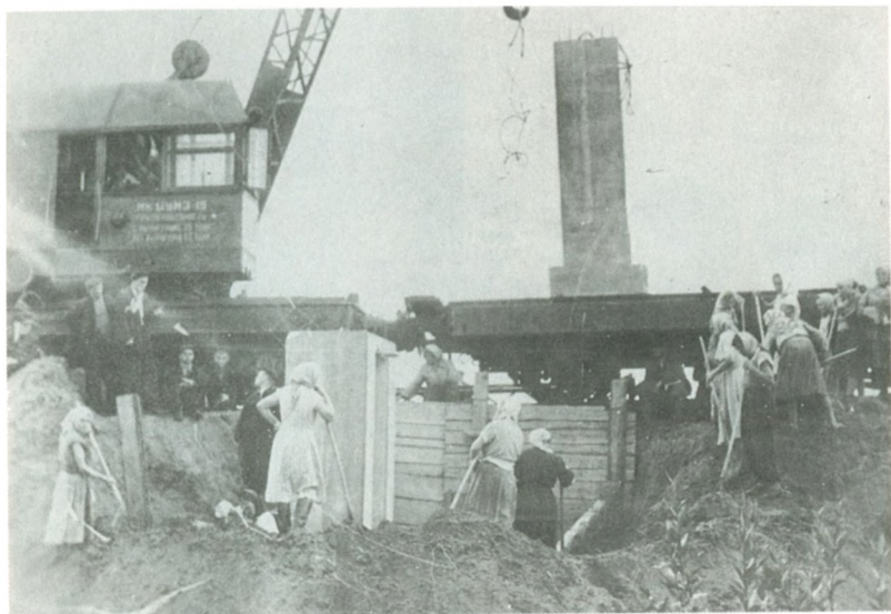
Бригады строителей В. Я. Жолобова и Павлова на установке опор контактной сети на станции Пролетарская.
