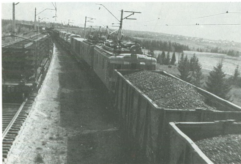
Пропуск состыкованных поездов по одному пути во время капитального ремонта пути на участке Пермь — Кунгур.
