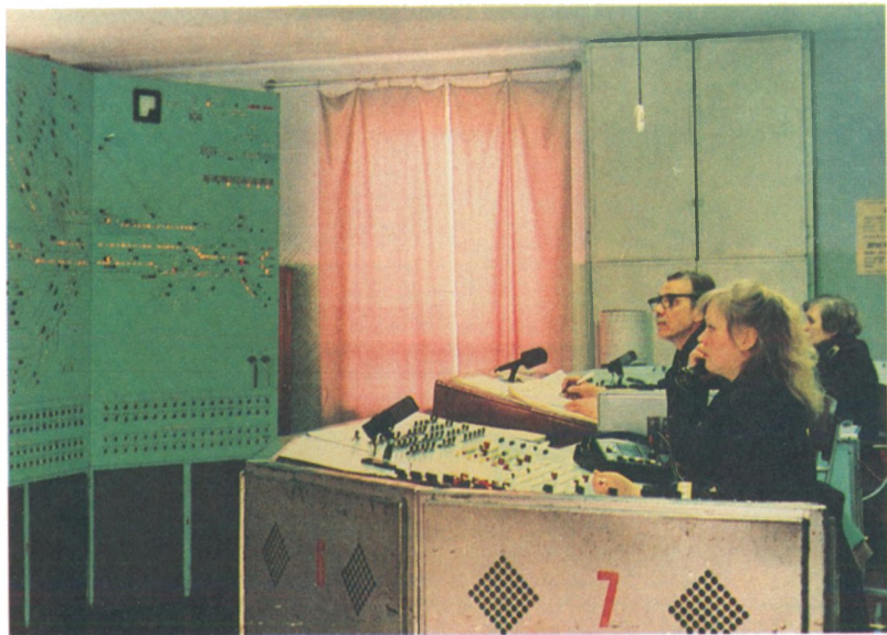
Руководитель движения поездов головной дежурный по станции Пермь П Г. М. Бурский контролирует на пульте табло БМРЦ (блочной маршрутно-релейной централизации) вход поезда в пределы пути станции.
