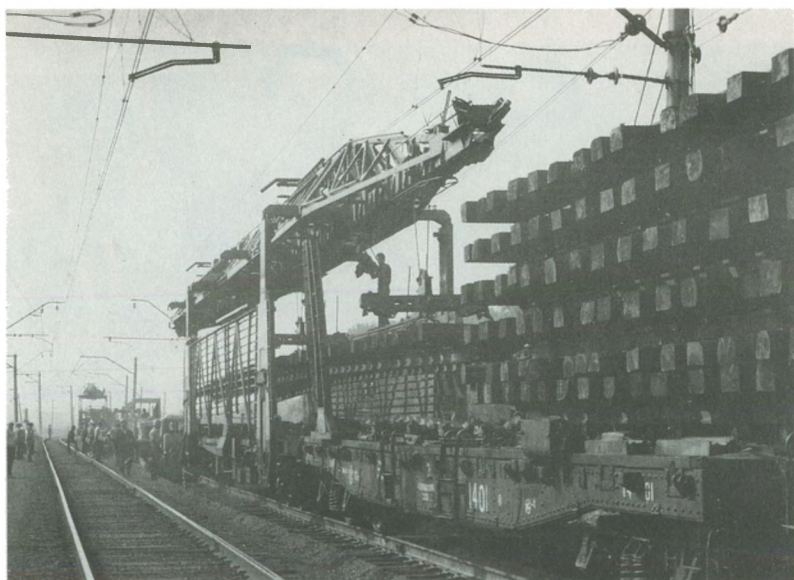
В отделении был разработан и внедрен пермский метод капитального ремонта пути в восьмичасовые «окна» при максимальной концентрации технических, материальных и людских ресурсов до начала массовых летних пассажирских перевозок. Перед началом «окна».
