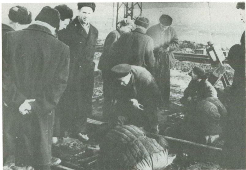
1963 год. Идет подготовка к включению первой стрелки горочной горловины в централизацию исполнительного поста.
