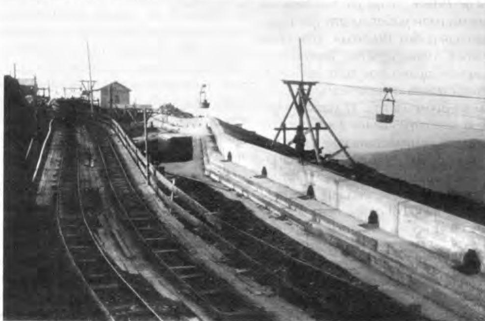
Форт № 2 Владивостокской крепости. Центральная линия огня. Канатная дорога и рельсы для ваго- неток. 1912 г. Из фондов РГВИА
