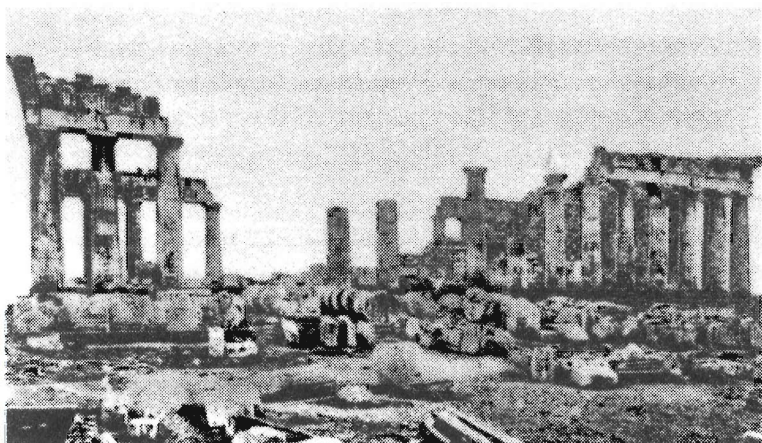
Рис. 13. Реконструкция Парфенона под руководством Баланоса. Результат его проекта (верхнее фото) выглядит более впечатляюще, чем руины (нижнее фото), с которых он начинал. Однако железные скобы, использованные во время реставрационных работ, вскоре стали угрожать разрушить тот мрамор, который должны были скреплять
