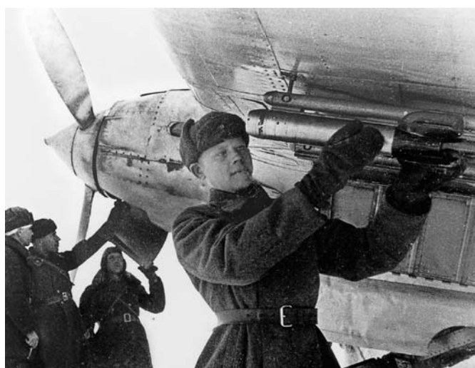
К крылу штурмовика Ил-2 крепят реактивные снаряды РС-82
