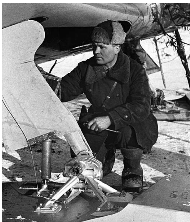
Для взлета по снегу колесное шасси иногда меняли на лыжное (техник А.Т. Доршин у истребителя Як-1)
