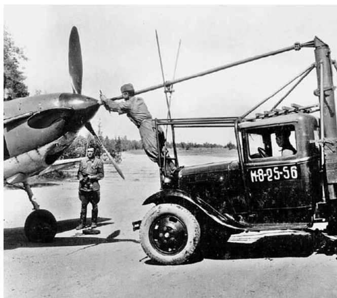
Запуск двигателя истребителя ЛаГГ-3
