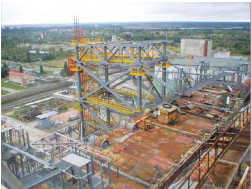
Рис. 6. Вид сверху на конструкции усиления
