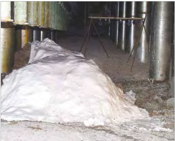
Рис. 9. «Куча» в ББ-1 после нанесения слоя ЭКОР для предотвращения разрушения поверхности ЛТСМ и распространения пыли
