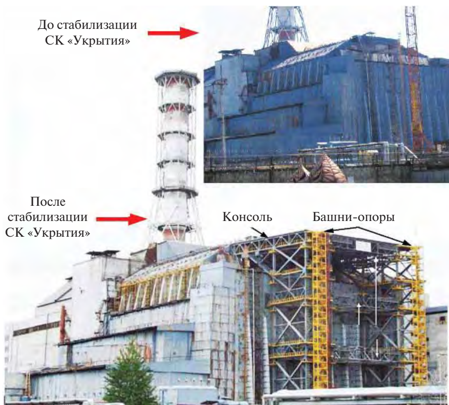
Рис. 4. Вид на «Укрытие» с запада до и после выполнения Мероприятия № 2
