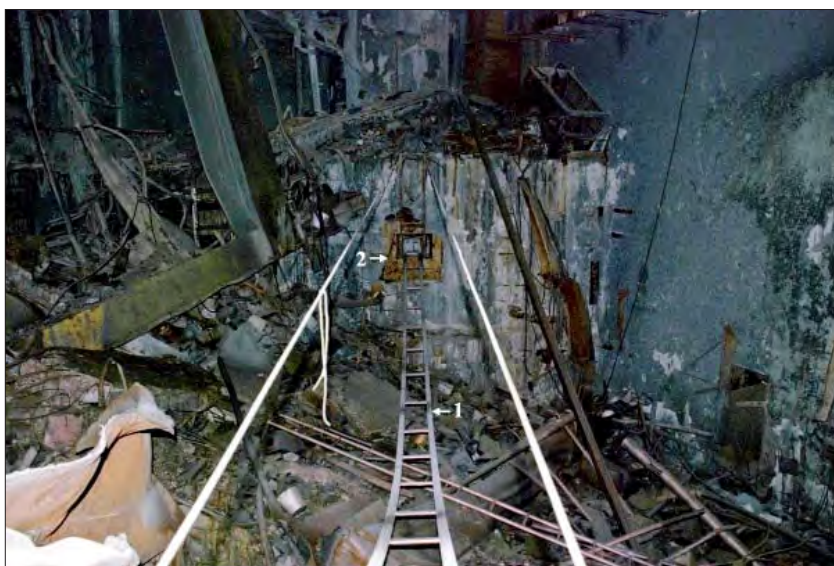
Рис. 34. Транспортные пути, рельсы (1), проложенные для передвижения ДУСА в центральном зале и выходящие из выбитого окна пультовой (2)
