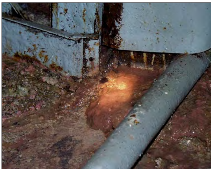
Рис. 23. Донные осадки (ил) вблизи от разделительной стены между 4-м и 3-м блоками
