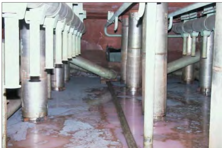
Рис. 2. Скопление воды в южной части ББ-2
