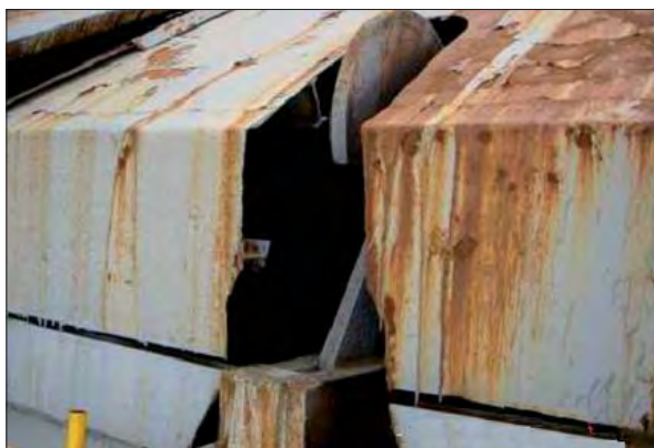
Рис. 5. Проемы в северных щитах-ключках в местах их опирания на северную контрфорсную стену (ось 44, отметка +54.500)
