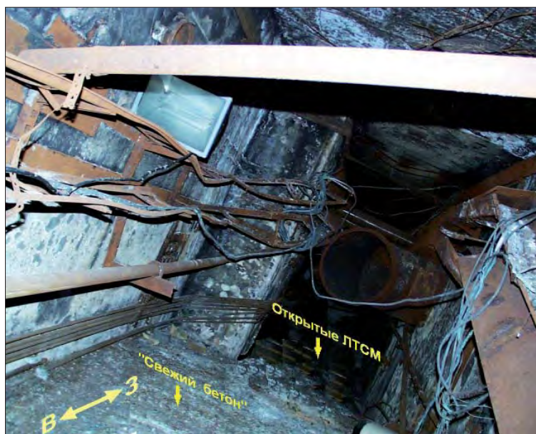
Рис. 23. Коридор 301/5. В нем за потоком «свежего» бетона, натекившим с востока (отмечен на рис.), за открытыми ЛТСМ, снова наблюдается поток «свежего» бетона, поступавшего с запада
