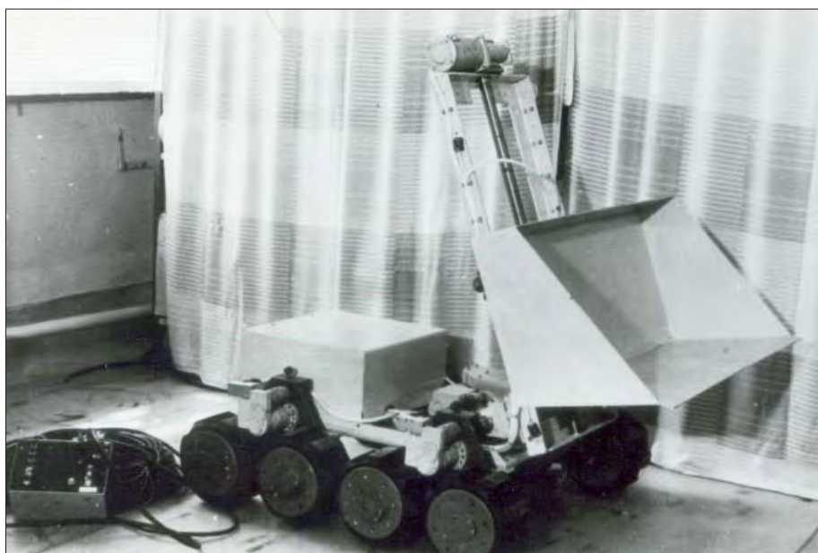
Рис. 30. ТР-7 с ковшом на подвижной платформе
