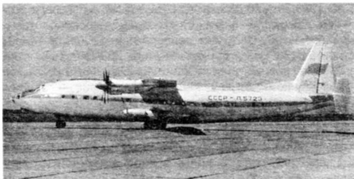
Ан-10 СССР – Л5723 с шайбами на стабилизаторе в ходе государственных испытаний
