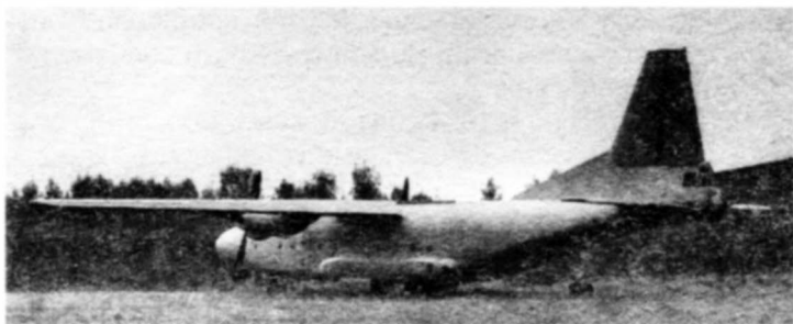
Первый отечественный военно-транспортный самолет Ан-8 с турбовинтовыми двигателями
