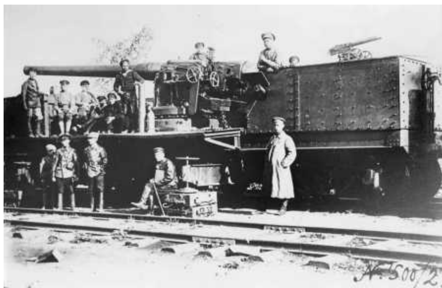
Тяжелая бронеплощадка красного бронепоезда «Атаман Чуркин» со 152/45>мм орудиями Кане
