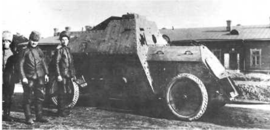
Бронеавтомобиль Ижорского завода на шасси автомобиля «Руссо-Балт». Вес – 3,3 т; мощность двигателя – 24 л. с.; вооружение – 3 пулемета «Максим»; броня – 3–5 мм
