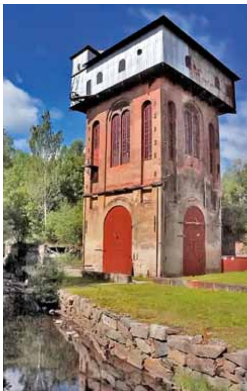
Древесноугольная доменная печь внутри здания, поддерживающего колошниковую площадку. Завод RYDDARSHYTAN, Швеция
