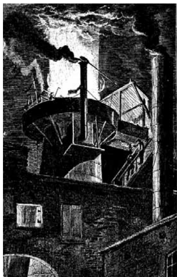
«Шотландская» доменная печь ранней конструкции с опорой шахты и кожуха на пилоны (завод в Швегате, Германия)
