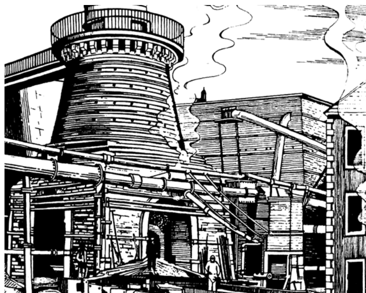
Переходная конструкция доменной печи с опорой шахты на пилоны и уменьшенной толщиной кожуха (завод Iron Works, Даулейс, Великобритания, ок. 1870 г.)
