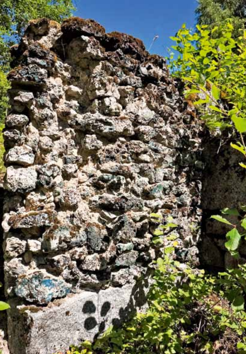
Остатки шлаковой кладки заводских строений доменного завода СТРЕМСДАЛ, Швеция
