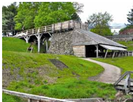
Доменная печь с навесом над литейным дво- ром и загрузоч- ным мостом. SAUGUS IRON WORKS, США. ФОТО D. ELKINS
