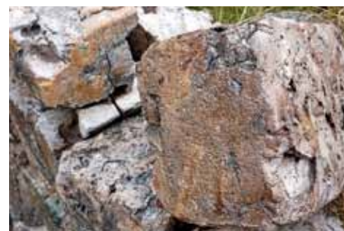
Кладка кожуха лещади доменной печи из литых шлаковых блоков. Завод Гаммелстилла, Швеция
