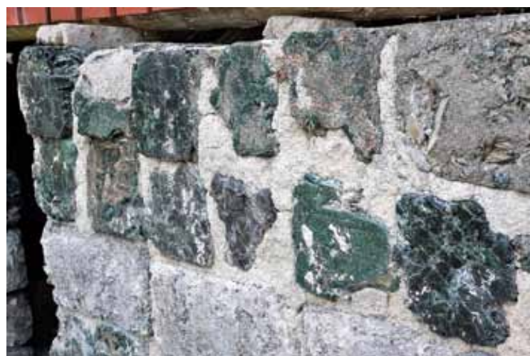
Остатки шлаковой кладки заводских строений доменного завода СТРЕМСДАЛ, Швеция
