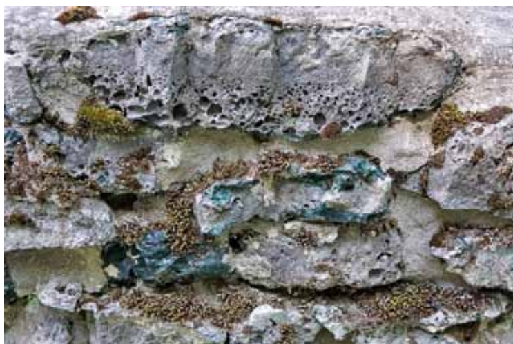
Комбинированная кладка известково-обжигательной печи из дикого камня и кусков шлака. Завод Кленсхюттан, Швеция
