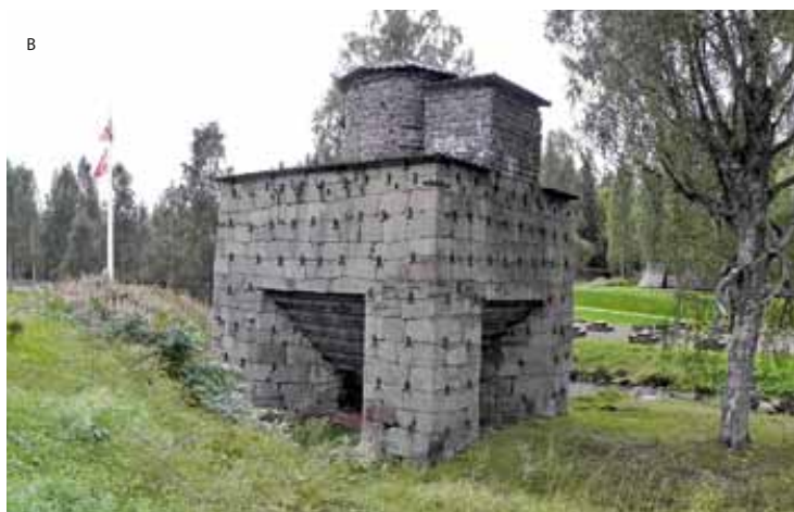
Шведские древесноугольные доменные печи XIX в. с теплоизолированным горном и заплечиками и открытой шахтой (а – доменная печь Тжърнърс, 1815-1881 гг.; б – доменная печь завода Едскен, середина XIX в.; в – доменная печь близ Вансбро (Vansbro), 1830-е гг.)
