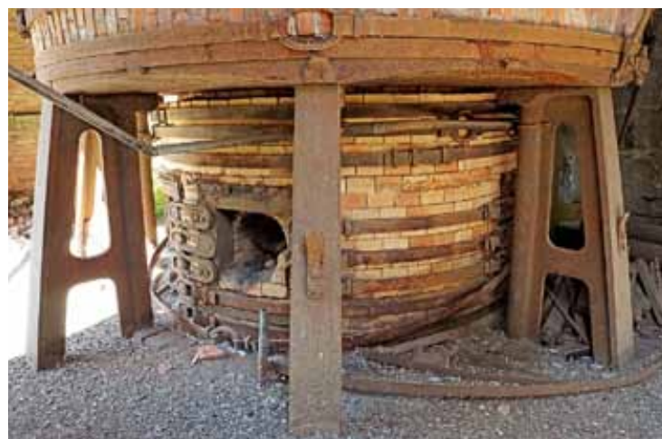
Древесноугольная доменная печь со свободно стоящей шахтой (завод Кленсхyttан, Швеция)
