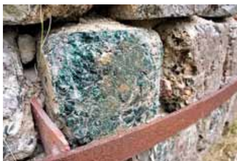
Кладка кожуха лещади доменной печи из литых шлаковых блоков. Завод Гаммелстилла, Швеция
