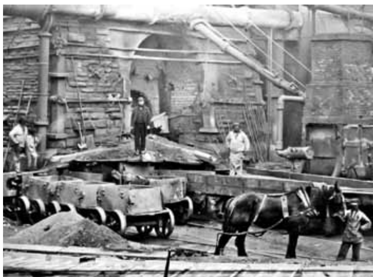
Переходная конструкция доменной печи с опорой шахты на пилоны и уменьшенной толщиной кожуха (завод Iron Works, Даулейс, Великобритания, ок. 1870 г.)
