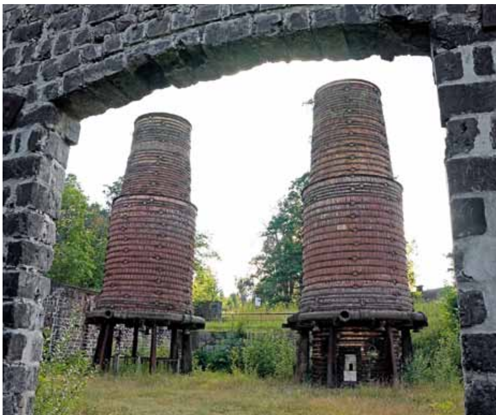
Древесноугольные доменные печи со свободно стоящей шахтой (завод HOGFÖRS, Швеция)
