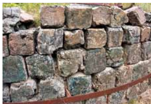
Кладка кожуха лещади доменной печи из литых шлаковых блоков. Завод Гаммелстилла, Швеция
