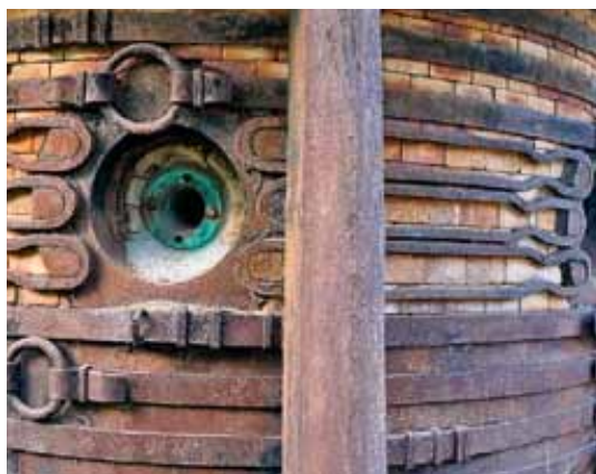
Водоохлаждае- мая АМБРАЗУРА и ФУРМЕННЫЙ ПРИ- БОР для подачи дутья (ФУРМА ОТСУТСТВУЕТ) (ДОМЕННАЯ ПЕЧЬ ЗАВОДА RIDDARHYTTAN, ШВЕЦИЯ)
