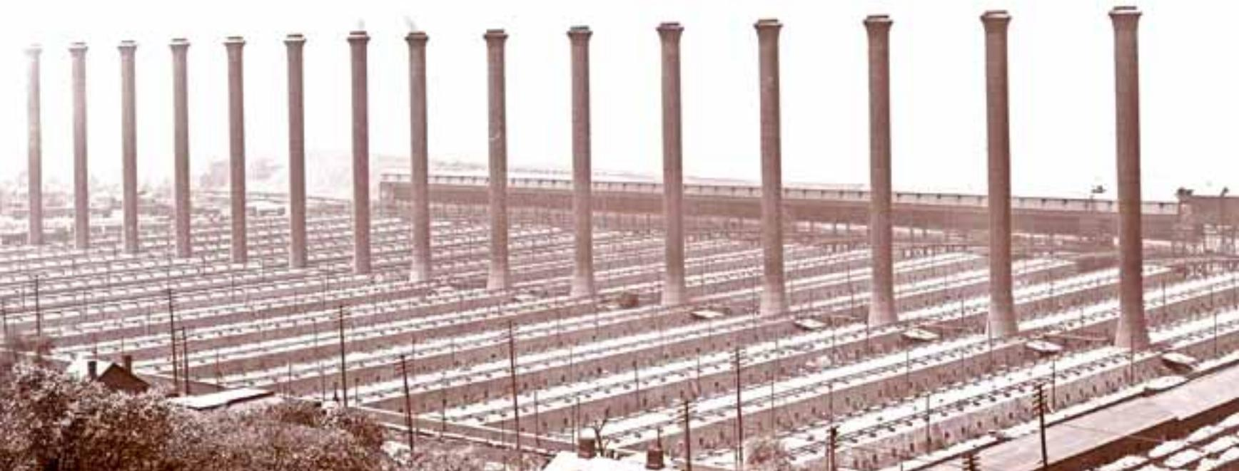
После окончания коксования дверь открывали, специальными клюшками выгребали кокс и заливали его водой. Для обеспечения непрерывности процесса загружать новую порцию угля было необходимо сразу же после выгрузки, пока кладка печи сохраняла высокую температуру. При коксовании в ульевых печах часть кокса неизбежно сгорала, однако выход его был на 10—15 % выше, чем при коксовании в кучах или шаумбургских печах.
