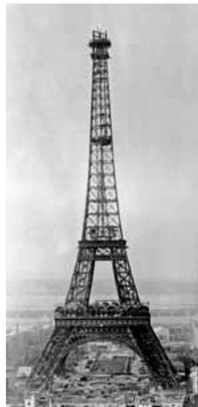
ческих деталей, для сборки которых использовали 2,5 млн заклёпок. Все расчеты Эйфеля и его команды отличались исключительной точностью. Применялись заранее изготовленные детали. Отверстия для заклёпок были просверлены на намеченных местах уже заранее, и две трети от 2,5 млн заклёпок закреплены на заводе Эйфеля в Левалуа-Перре. Ни одна из заготовленных балок не весила больше 3 т, что существенно облегчало поднятие металлических частей на предусмотренные места.
