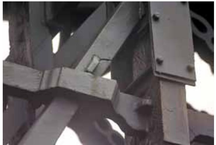
ЭЛЕМЕНТЫ КОНСТРУКЦИИ ЧУГУННОГО МОСТА
