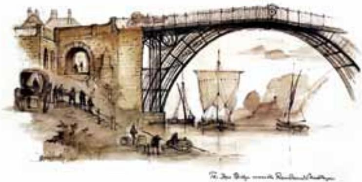
*Первой большой чугунной конструкцией стал мост через реку Северн. Длина пролета моста составляет 30,6 м, его масса – 384 т.*
