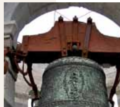
«ЕВРОПЕЙСКОЕ» КРЕПЛЕНИЕ КОЛОКОЛА ПИЗАНСКОЙ БАШНИ – КОЛОКОЛЬНОЙ БАШНИ СОБОРА САНТА-МАРИА АССУНТА (ВНИЗУ ВИДЕН ЭЛЕКТРИЧЕСКИЙ МЕХАНИЗМ БОЯ).
