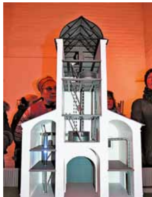
Водовзводная башня в Коломенском, действующий макет экспозиции «Государевое водовзводное дело»
