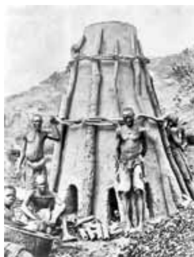
Высокий сыродутный горн из Африки (начало XX в.); принципиальная схема процесса и фото
