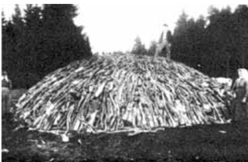
Кучи для выжигания угля: ВВЕРХУ – ИЗОБРАЖЕНИЕ КУЧИ ДЛЯ ПРОМЫШЛЕННОГО ВЫЖИГА УГЛЯ ИЗ РУКОВОДСТВА ПО МЕТАЛЛУРГИИ XIX в.; В СЕРЕДИНЕ И ВНИЗУ – КУЧИ, ИСПОЛЬЗОВАВШИЕСЯ В ФИНЛЯНДИИ (1900 г.)
