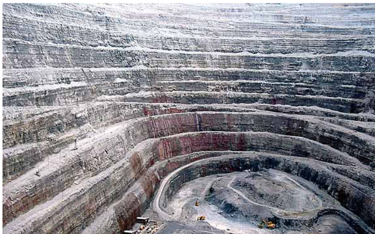
Карьер на кимберлитовой трубке «Зарница» (июль 2004 г.). Кольцевые уступы – дороги, по которым идут стотонные самосвалы (по Е. Б. Трейвусу)
