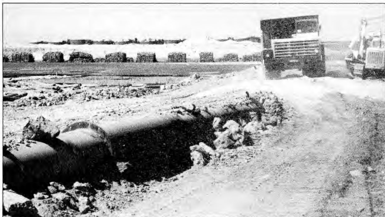
Начало строительства котлована на месте будущего судопропускного сооружения С-1. На заднем плане ряжевые заграждения XIX в.
