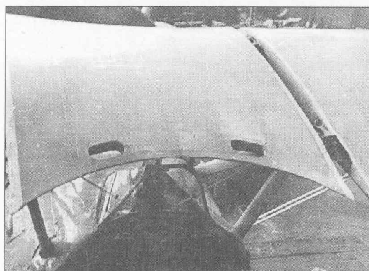
Центроплан верхнего крыла ДИТ имел отверстия в районе задней кромки, чтобы держаться при посадке в переднюю кабину. На представленном снимке стыки соединения верхнего крыла и центроплана не закрыты металлической лентой
