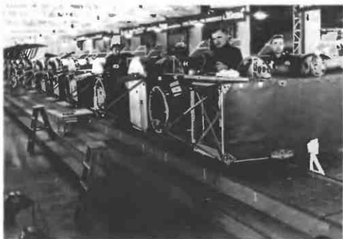
Рис. 3.2. Конвейерная сборка самолетов У-2 на заводе № 23
