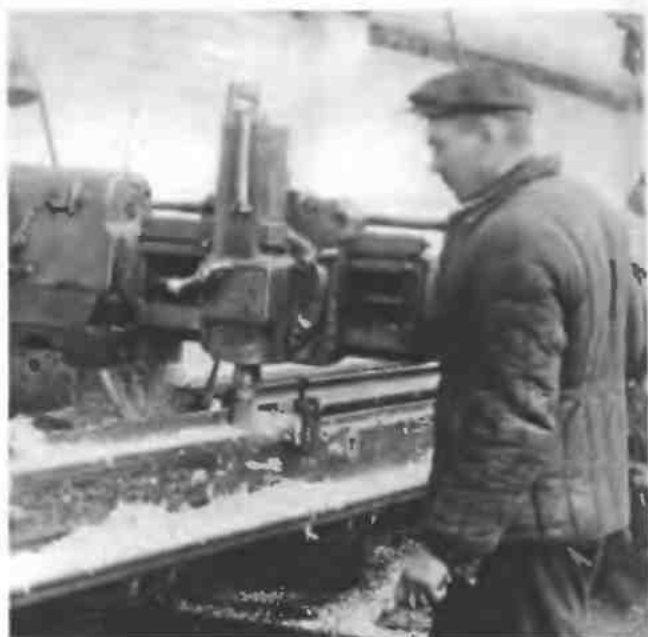
Рис. 5.8. Фрезерование полок лонжерона. 1949 г.
