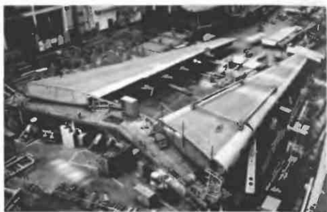
Рис. 6.14. Сборка крыльев для «Руслана» на заводе в Ташкенте
