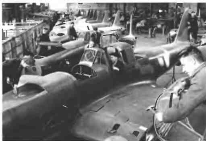
Рис. 4.8. Поточное производство штурмовиков Ил-2 на заводе в Куйбышеве
