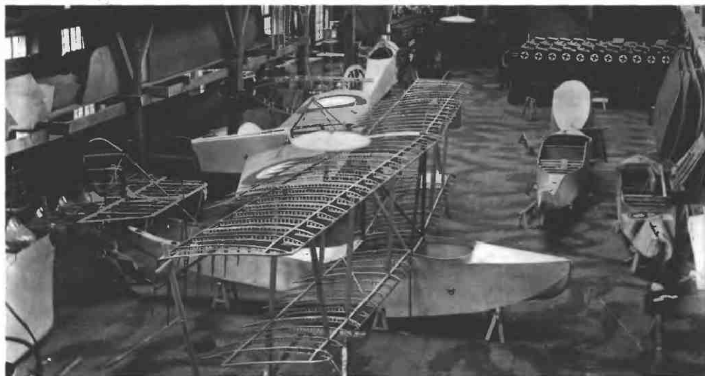
Рис. 1.7. Изготовление летающих лодок М-5
