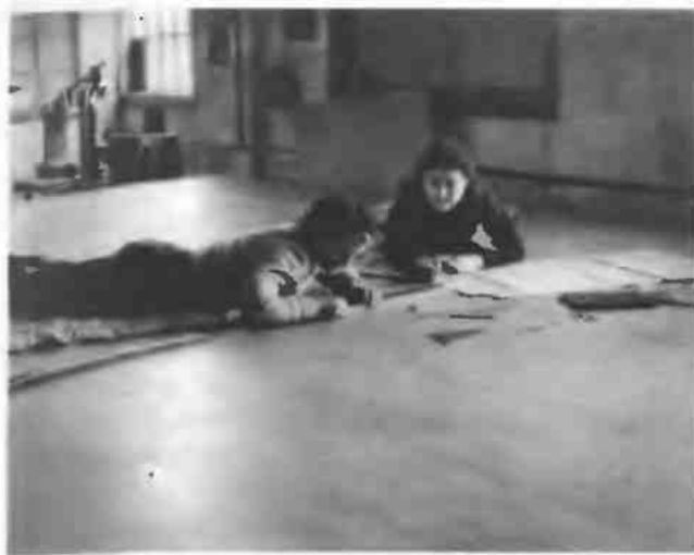
Рис. 4.9. Изготовление плазов бомбардировщика Ер-2
