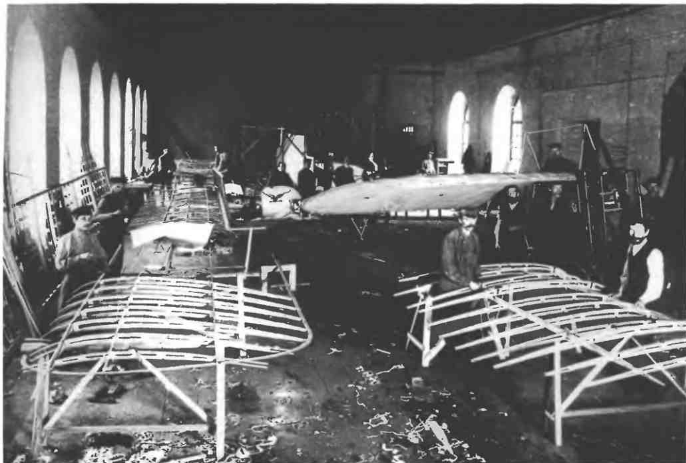
Рис. 1.2. Завод Первого русского товарищества воздухоплавания. Изготовление самолетов «Россия Б». 1910 г.
