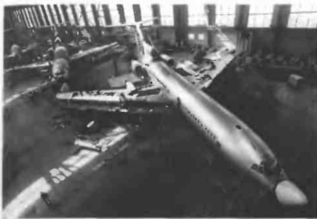
Рис. 6.6. Сборка Ту-154 на Куйбышевском авиазаводе. 1972
