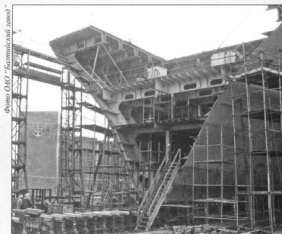
Сборка корпуса первого парома проекта «Optima» на стапеле Балтийского завода, 16 августа 2005 года
