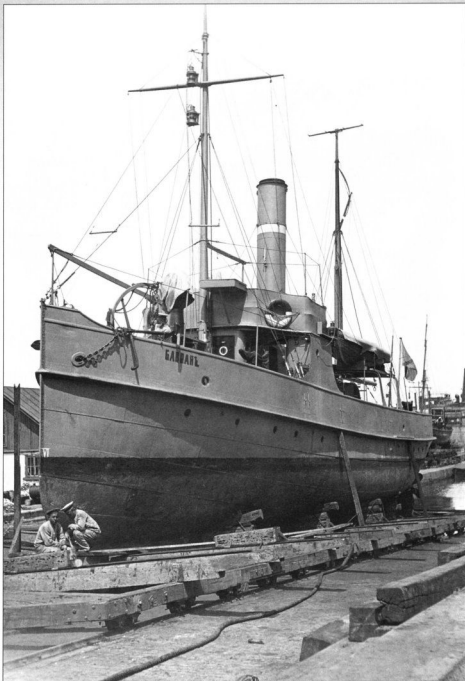
Портовое судно «Баклан» и однотипный с ним «Амбатрос» стали первыми в отечественном флоте судами специальной постройки, приспособленными для траления мин
