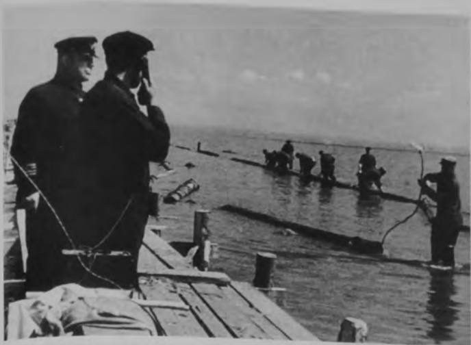
Монтаж плетей Ладожского бензинопровода. Июнь 1942 г.
