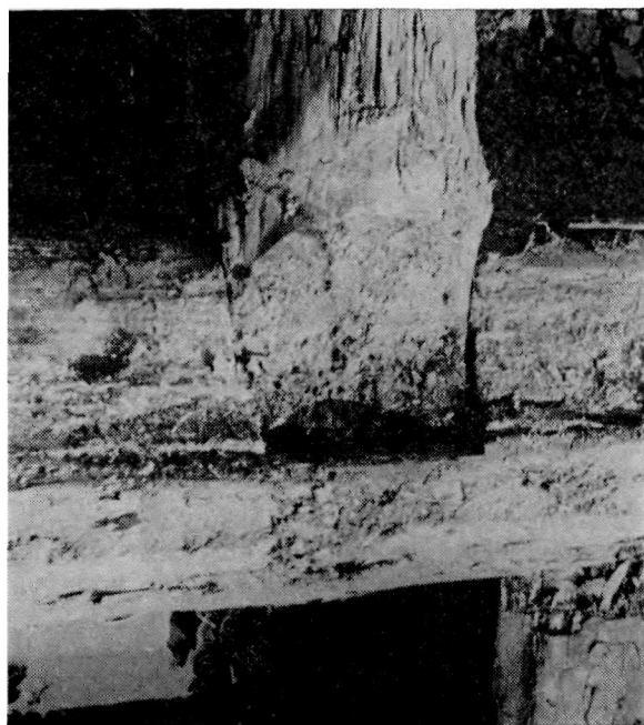
Рис. 22. «Глухая врубка» переводины (сруб 7М)
