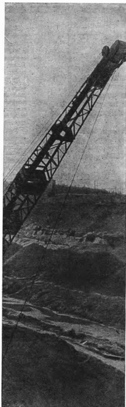
Около Хлебникова экскаваторы работали на глубокой выемке. Здесь глубина канала достигает 24 метров. Выработка экскаваторов за час работы достигла в этот день 240-290 кубометров
