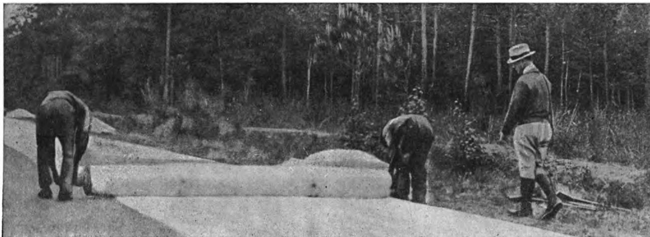
Опыт нового покрытия дороги в штате Миссури: покрытием служит хлопчатобумажная ткань, пропитанная особой смесью из глины, гравия, смолы и асфальта
