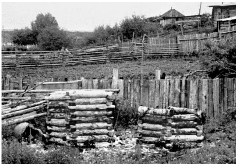
Рис. 21. Заготовки колодезных срубов. Чуваш. Прииртышье. (1987 г.). Фотоархив МАЭ ОмГУ. Оригинал. Фото автора.
