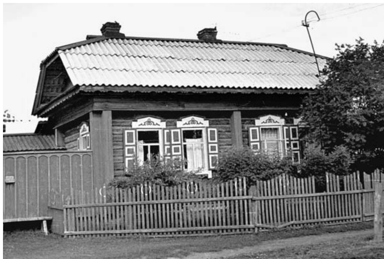
Рис. 15. Рубленый дом-пятистенок (1-я пол. XX в.). Чуваш. Прииртышье (1987 г.) Фотоархив МАЭ ОмГУ. Оригинал. Фото автора.
