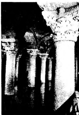
Рис. 309. Закрытая цистерна Юстиниана в Константинополе с 336 колоннами, поддерживающими камарный свод (по К. Мэнго)
