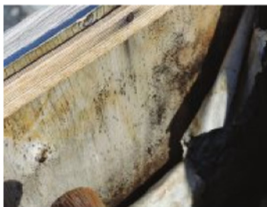
Рис. 4.8. Жилые и строительные объекты, поврежденные плесневыми грибами
