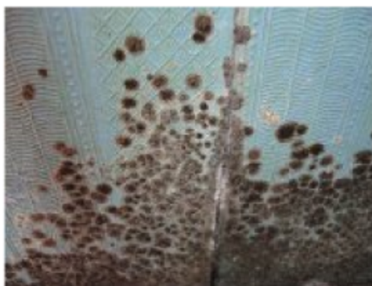
Рис. 4.8. Жилые и строительные объекты, поврежденные плесневыми грибами
