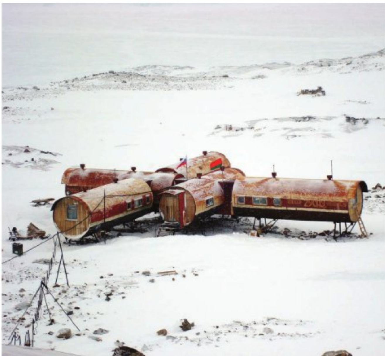
Рис. 1.11. Комплекс цельнометаллических унифицированных блоков
