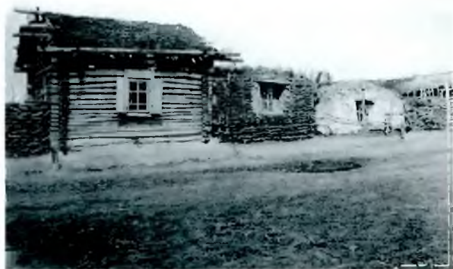
Рис. 186. Избы: бревенчатая; из двойного плетня; плетневая, обмазанная глиной. Катайцы
