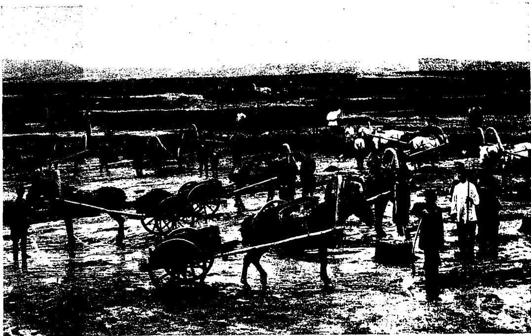
Снятіе торфовъ—слоевъ, покрывающихъ золотоносный пластъ (Забайкальская обл.).
