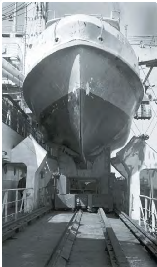
Тележка везет РДС для установки на кильблоки
