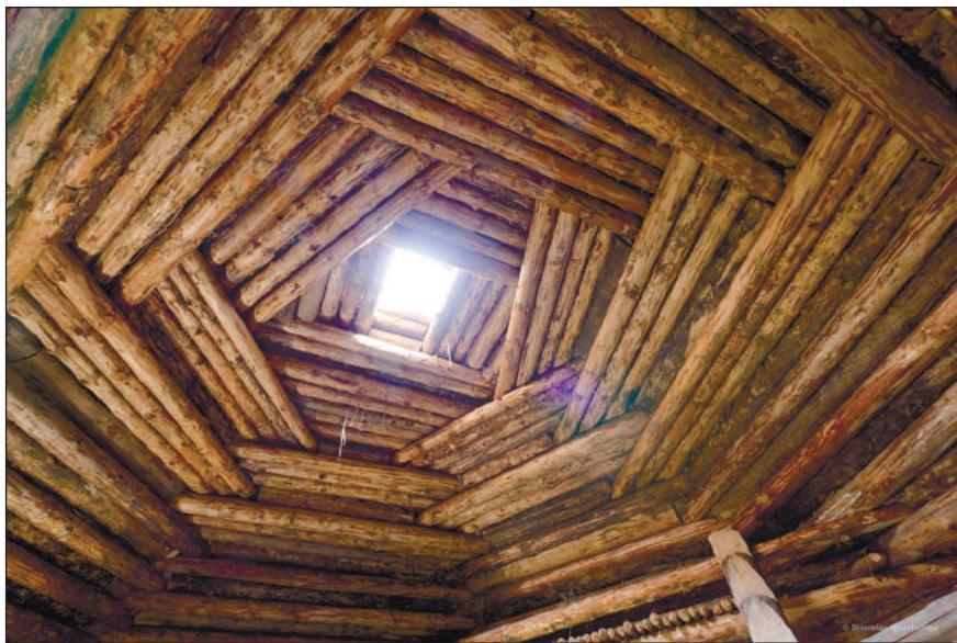
Фото 8. Фрагмент конструкции жилища, купольное перекрытие
