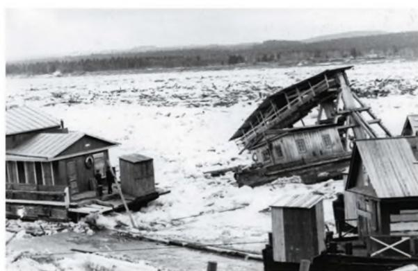
В апреле 1963 года на Ново-Ильинском рейде произошла крупная авария — ледоходом были сорваны и унесены вниз по течению самоходный и несамоходный флот, наплавные сооружения, боны, плитки, прикольные точки, плитки запаней, затонули 4 дебаркадера и катер, были повреждены несколько катеров, пароходов и понтонов, разнесена на много километров сплавляемая древесина.
