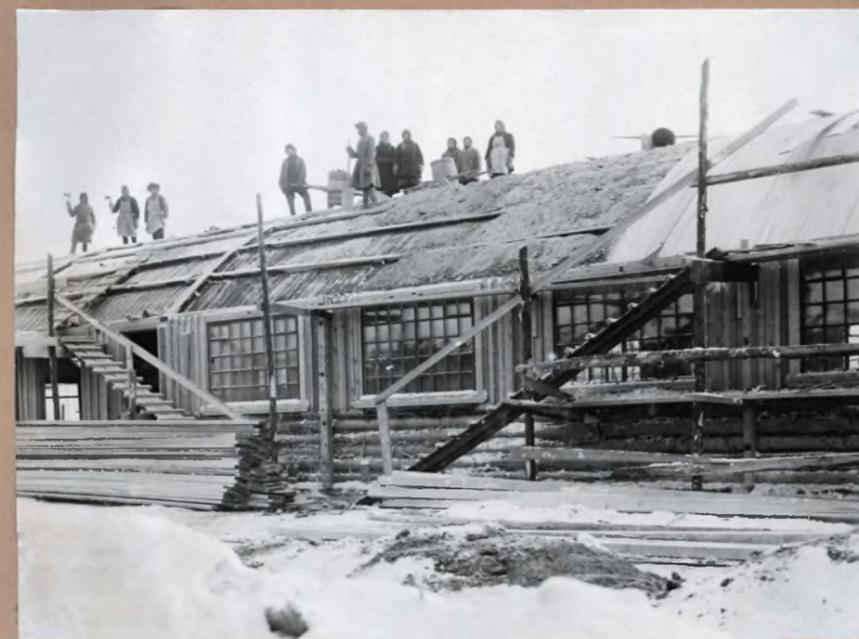
312. Барачное строительство. Окончание перекрытия типа Шухова. (В. Плотский). Снято 6/11-31 г.
