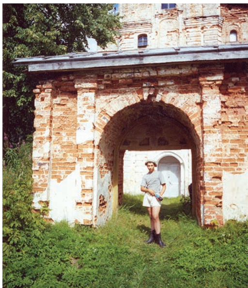
Кирпичная ограда у входа в храм ещё сохранилась
