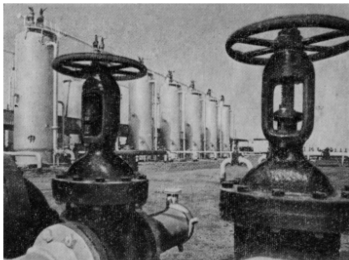
Нефтесборный пункт (центр), где нефть отделяют от газа, который тут же сжижают
