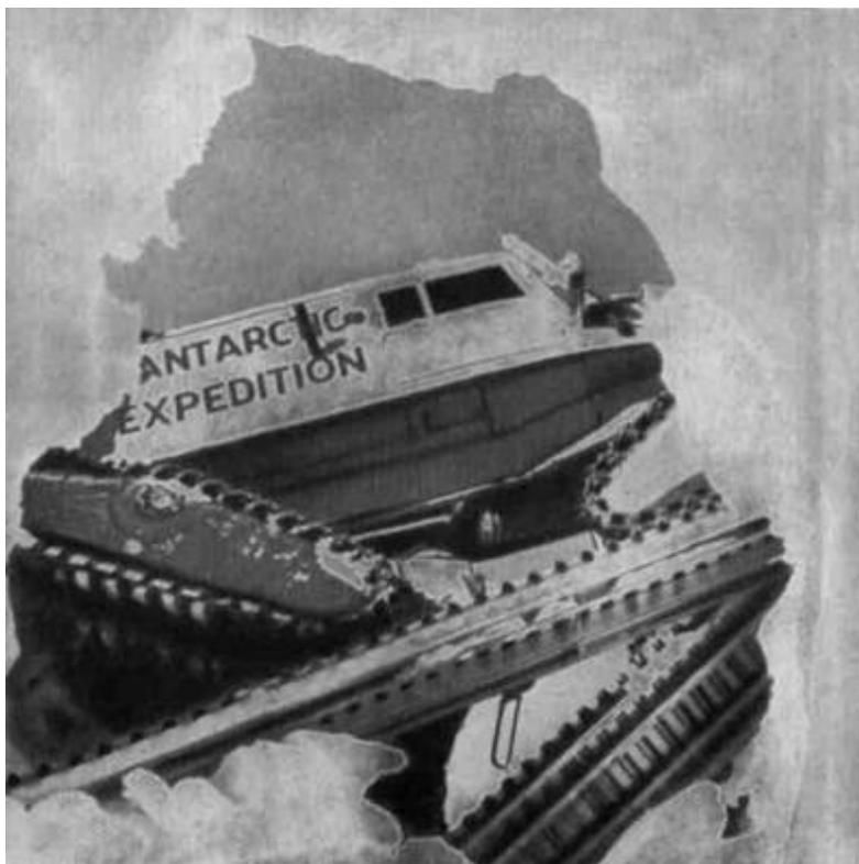
Вытаскивание сноу-кэта «Эйбл» из трещины с помощью легких алюминиевых мостовых ферм
