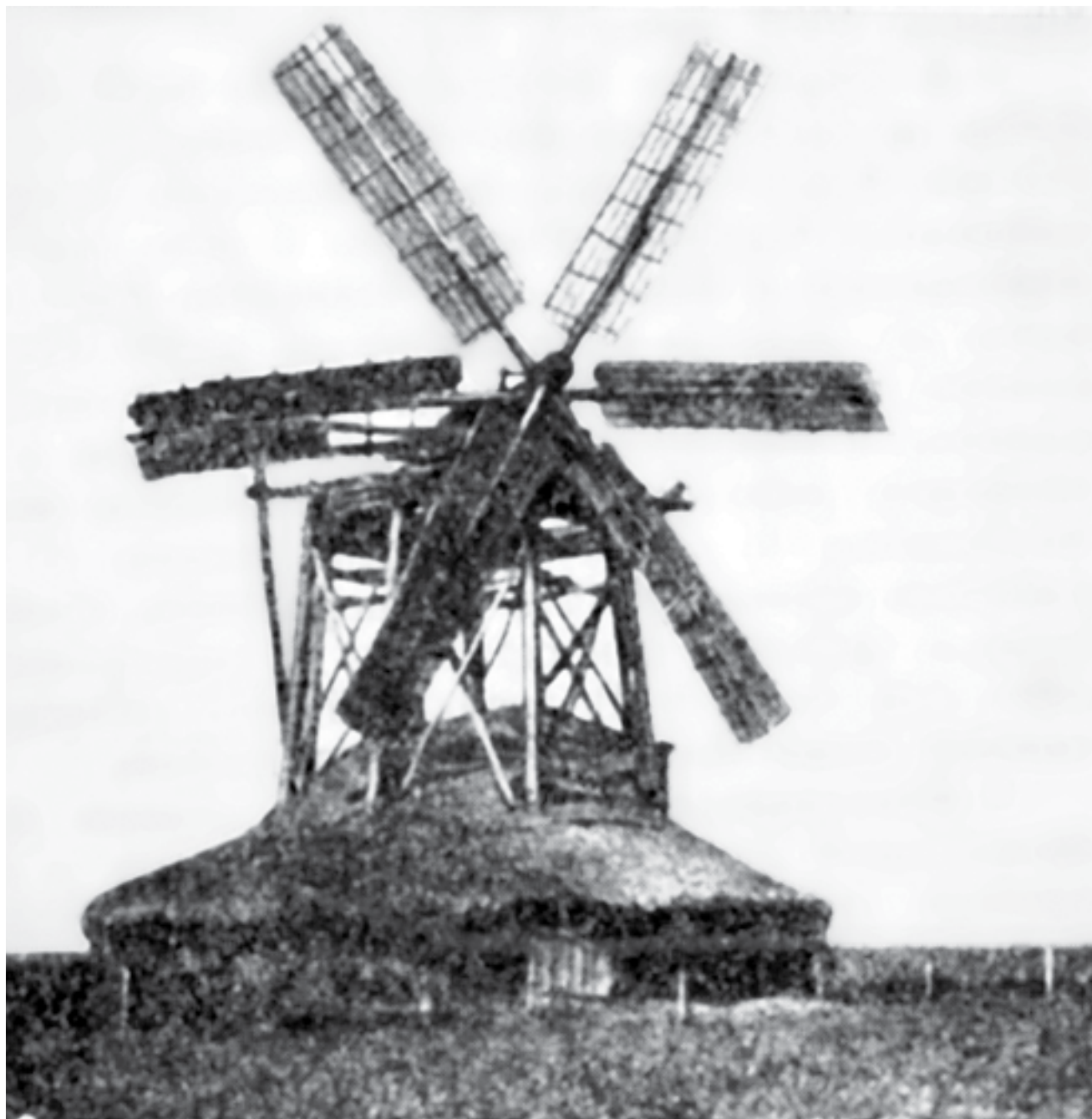
Шестикрылая шатровая ветряная мельница с плетеным низом, крыта соломой. С. Даниловка Епифанского уезда Тульской губернии. Материалы Е.Э. Бломквист.
