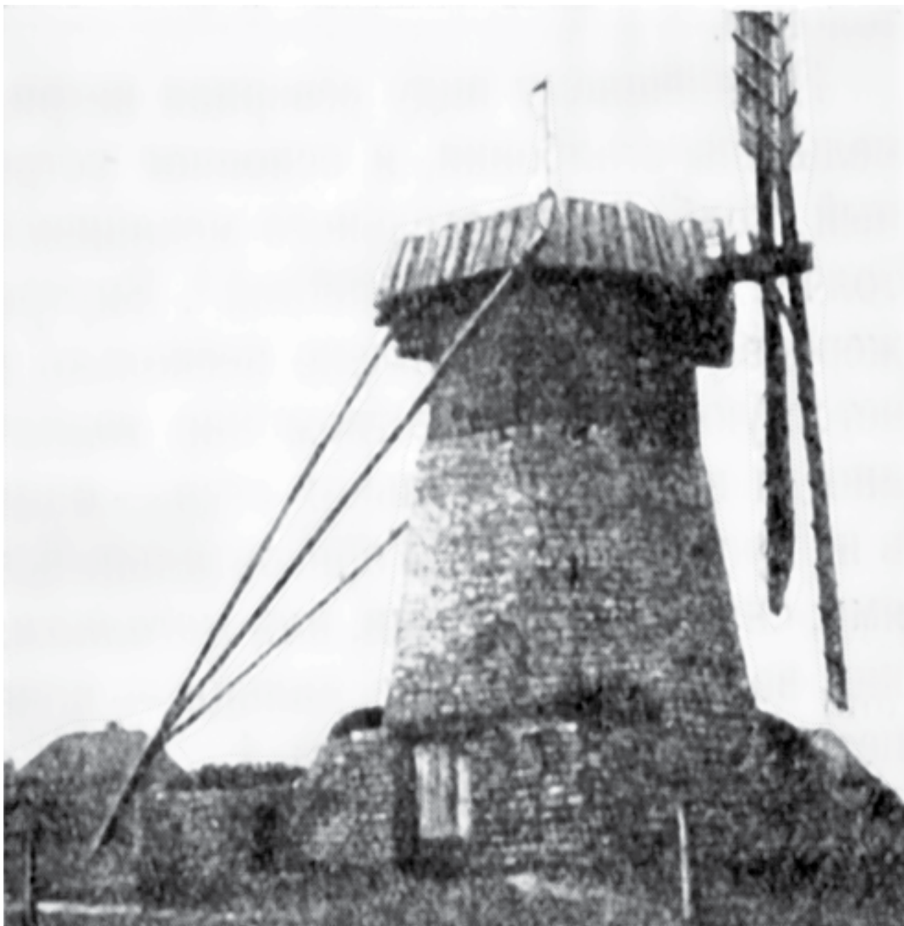
Шатровая ветряная мельница, низ сложен из известняка, верх – рубленный из дерева. С. Донская Негочевка Задонского уезда Воронежской губернии. Материалы Е.Э. Бломквист.
