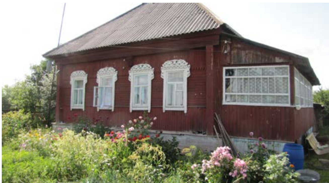
Дом на цементном фундаменте. Наличники с протильной резьбой. Пос. Кустаревка, Сасовский район
