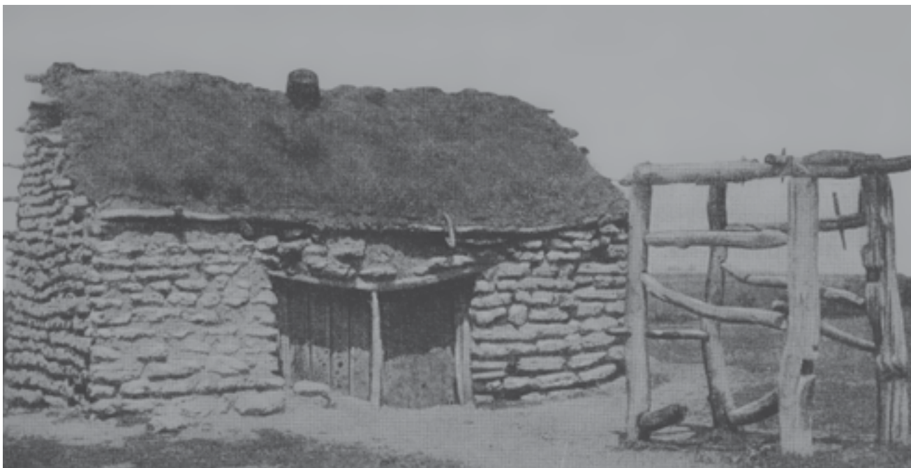
Кузница, сложенная из плитняка, в станок для ковки лошадей. С. Нижняя Залегощь Новосильского уезда Тульской губернии. Материалы Е.Э. Бломквист.
