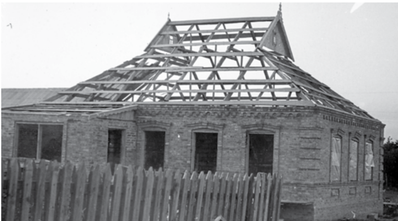
Конструкция полувальмовой крыши строящегося кирпичного дома. Белгородская область Материалы Л.Н. Чижиковой.
