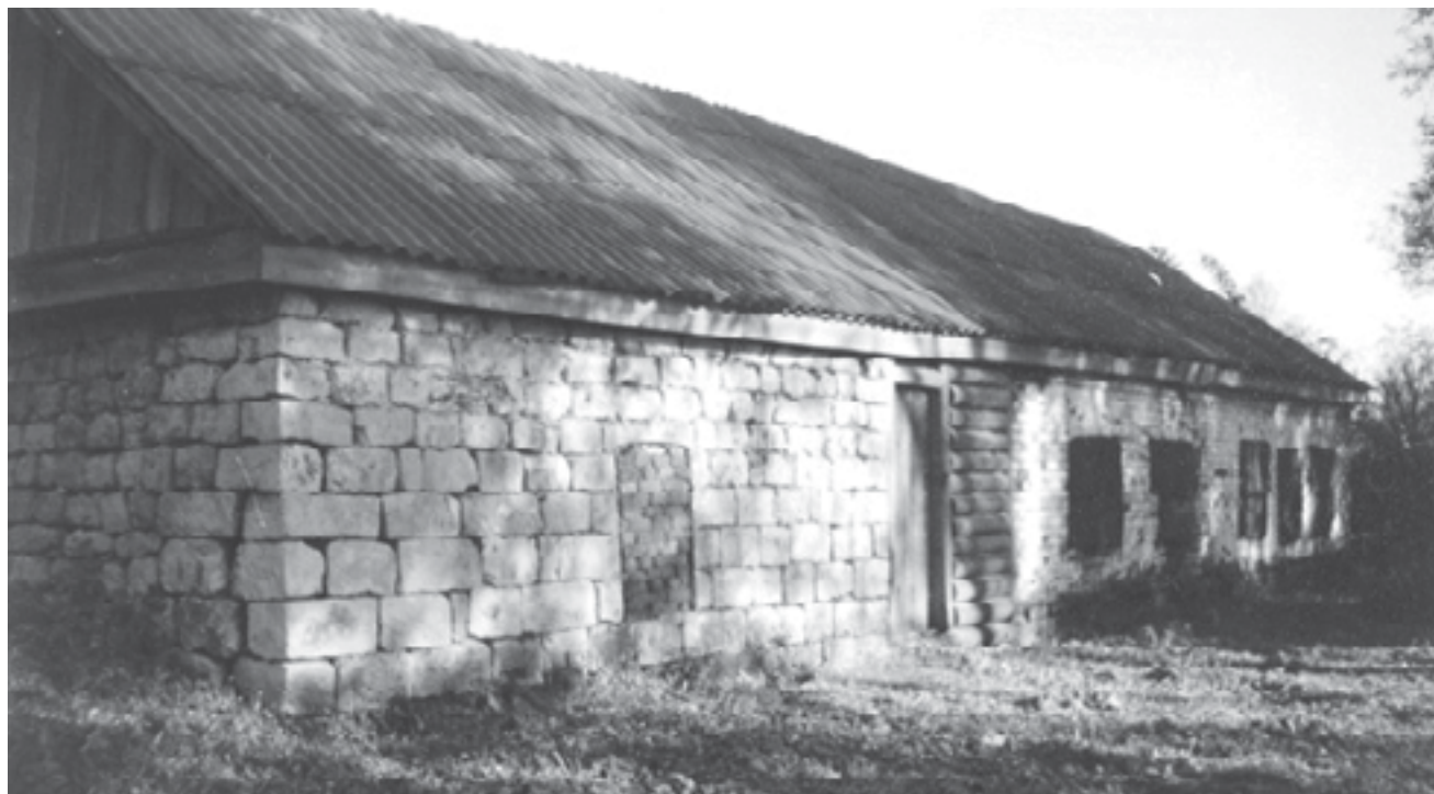
Дом, построенный из разных материалов: изба – из кирпича местного производства, хозяйственная часть (клеть) – из природного камня, сени – из дерева (рублены «в заплот») с.Маково, Михайловский район, Рязанская область. Фото В.А. Липинской, 2000 г.
