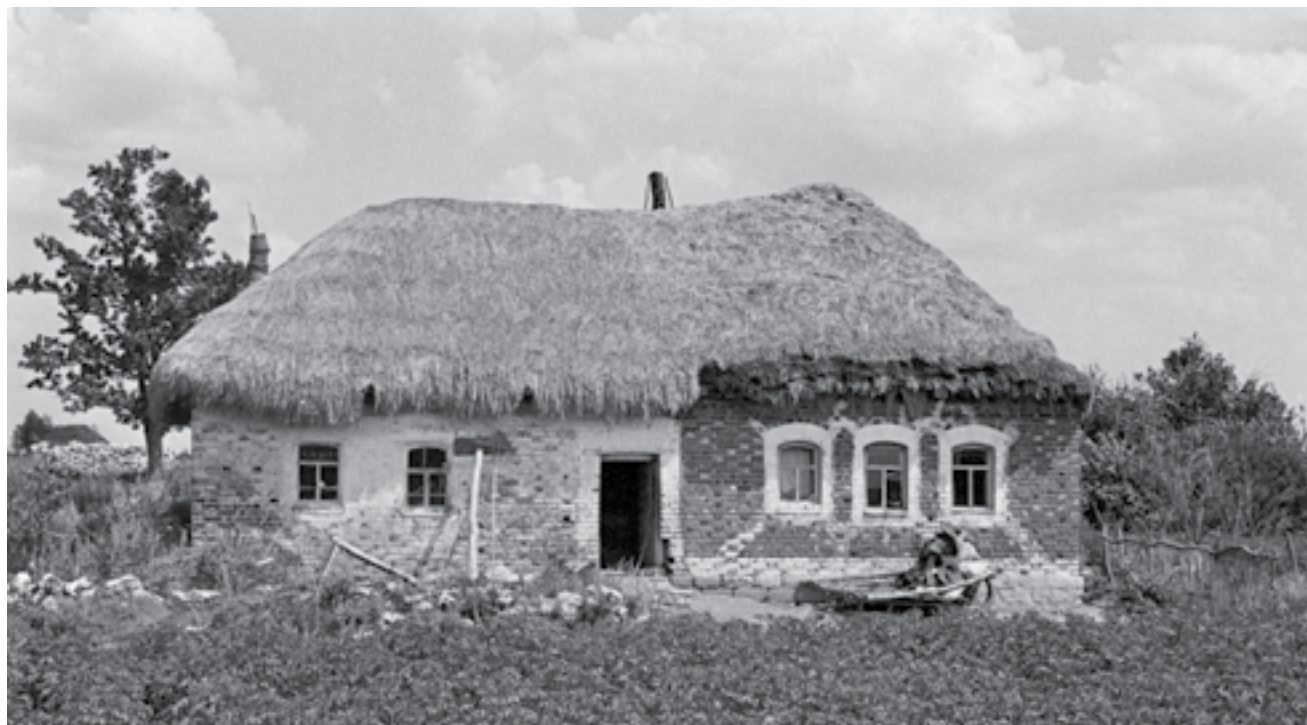
Дом построен из разных материалов: в старой половине из природного камня, в более новой половине – из местного кирпича с фундаментом в декором из природного камня. Материалы Г.С. Масловой
