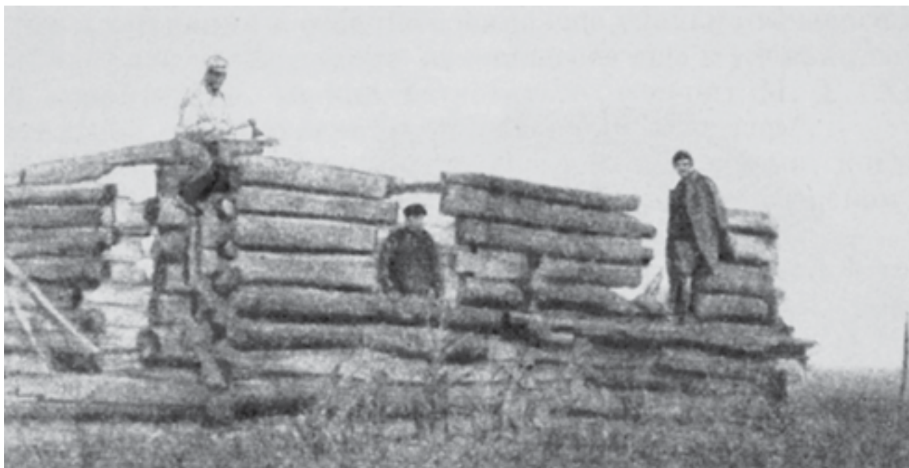
Сборка сруба плотниками. Сумская область Материалы В.А. Горелова.
