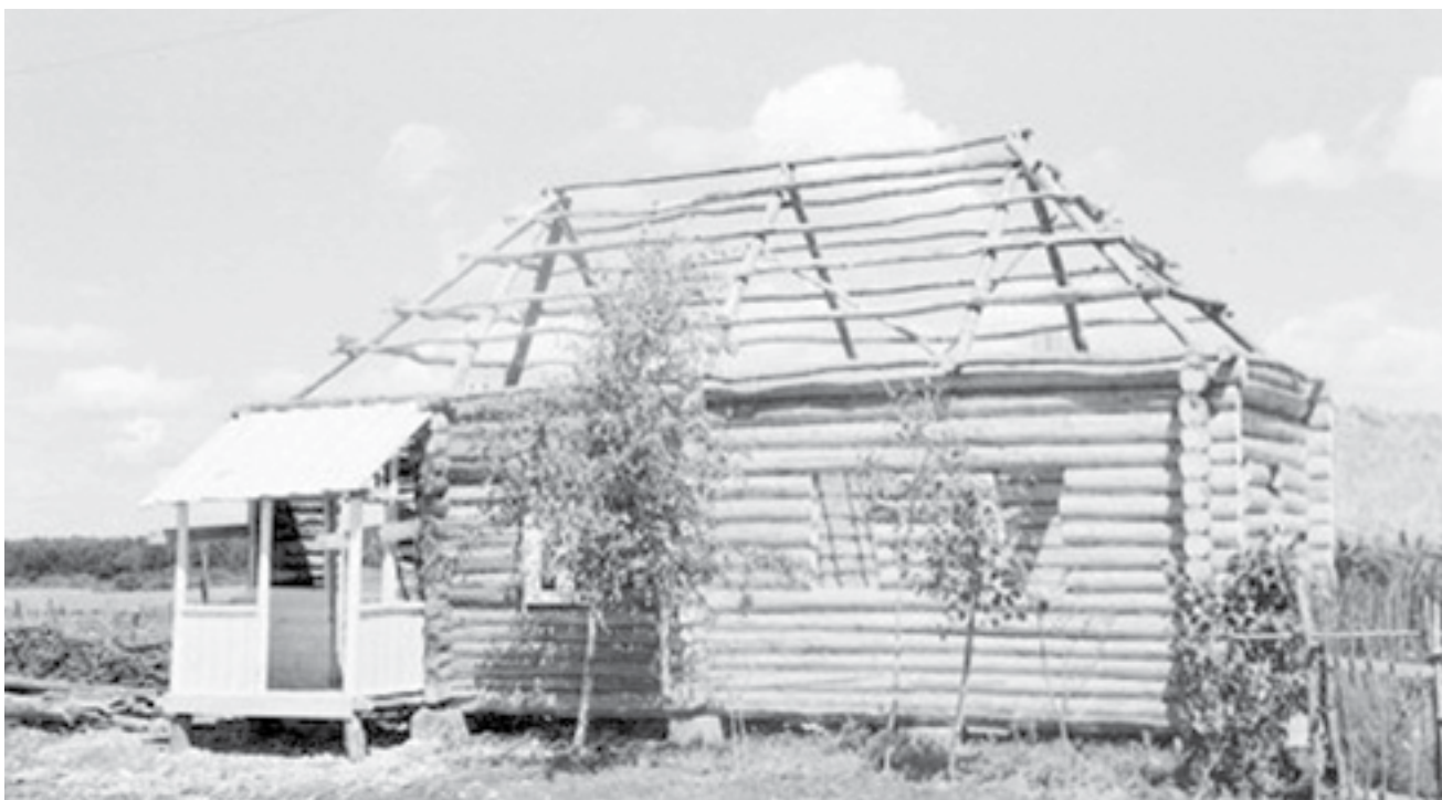
Строящийся срубный дом с конструкцией крыши на слегах. С. Вирятино Тамбовской обл. Материалы В.Ю. Крупянской.
