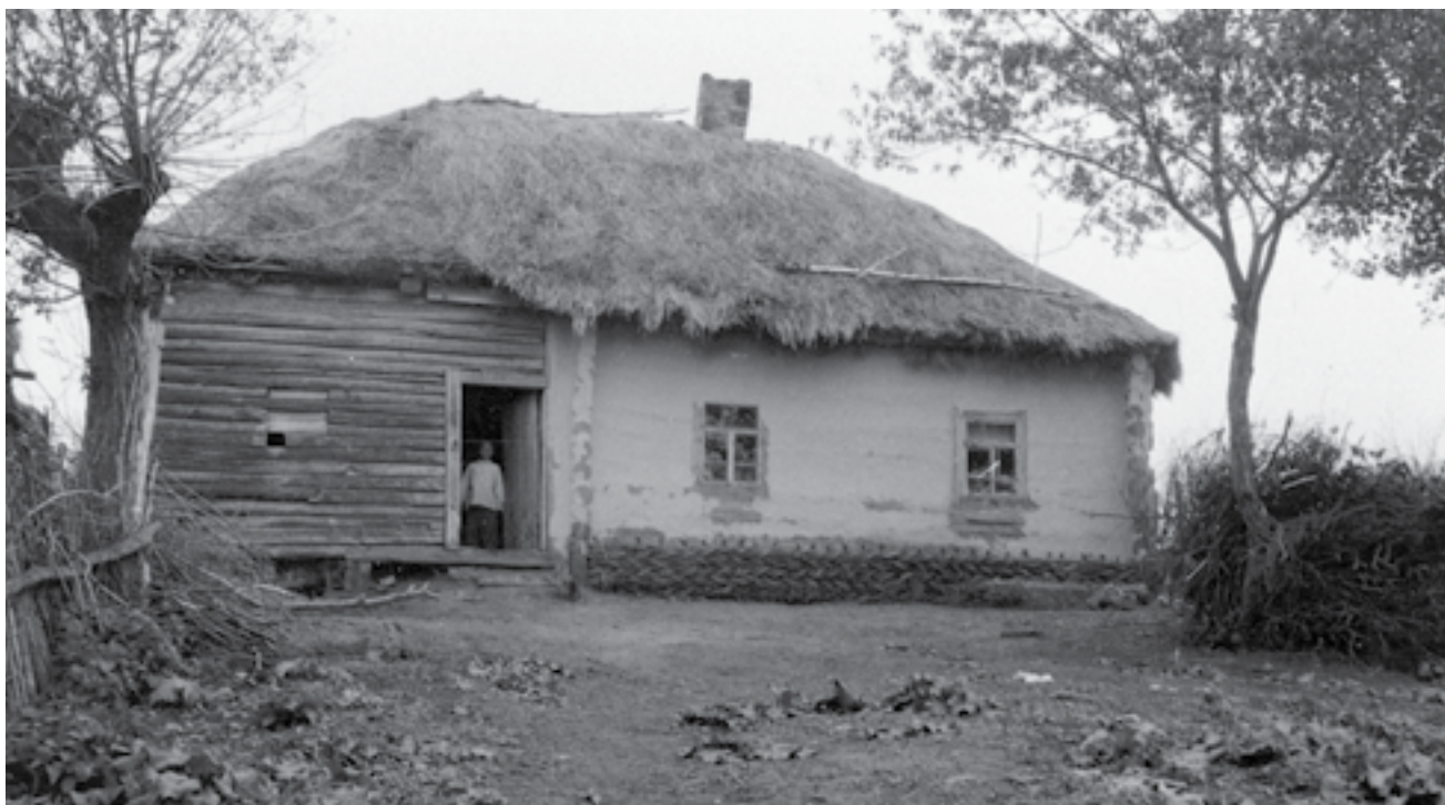
Воронежская обл. Дом, построенный в первой половине XX в. в разной технике строительства: хата рублена «в угол», сени – «заплот», по плану (изба + сени).
