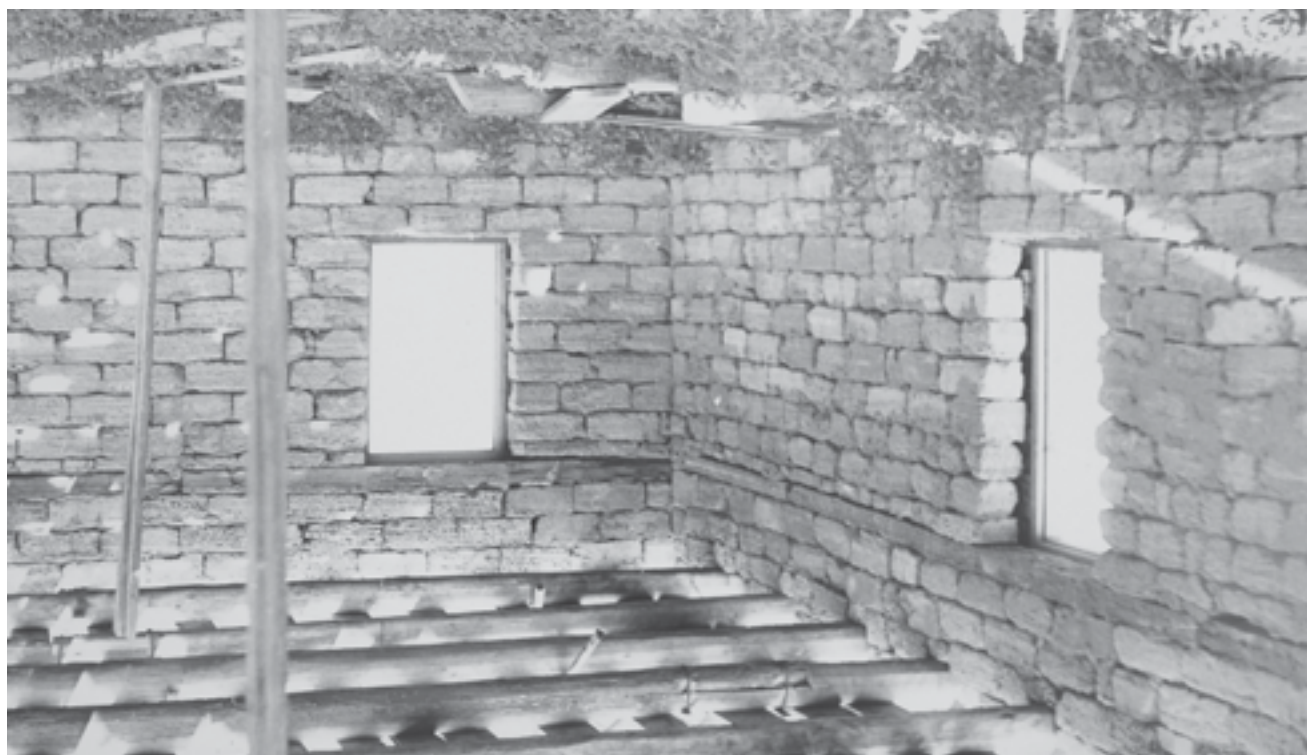
Фрагменты кладки стен из самана. Материалы Л.Н. Чижиковой.
