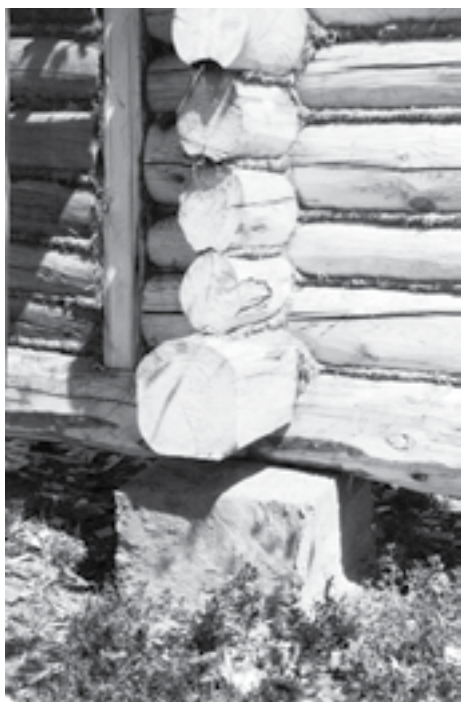
Угол дома, рубленного «в угол». Сруб поставлен на кирпичноцементном стуле. Тамбовская область, с. Вирятино. Материалы В.Ю. Крупянской. Фото В.В. Вентцеля, 1954 г.
