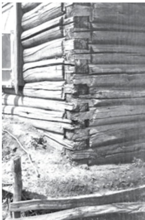
Угол дома, рубленного «в лапу». Дом с «завалинкой». Орловская область. Материалы О.А. Ганцкой. Фото В.В. Вентцеля, 1954 г.
