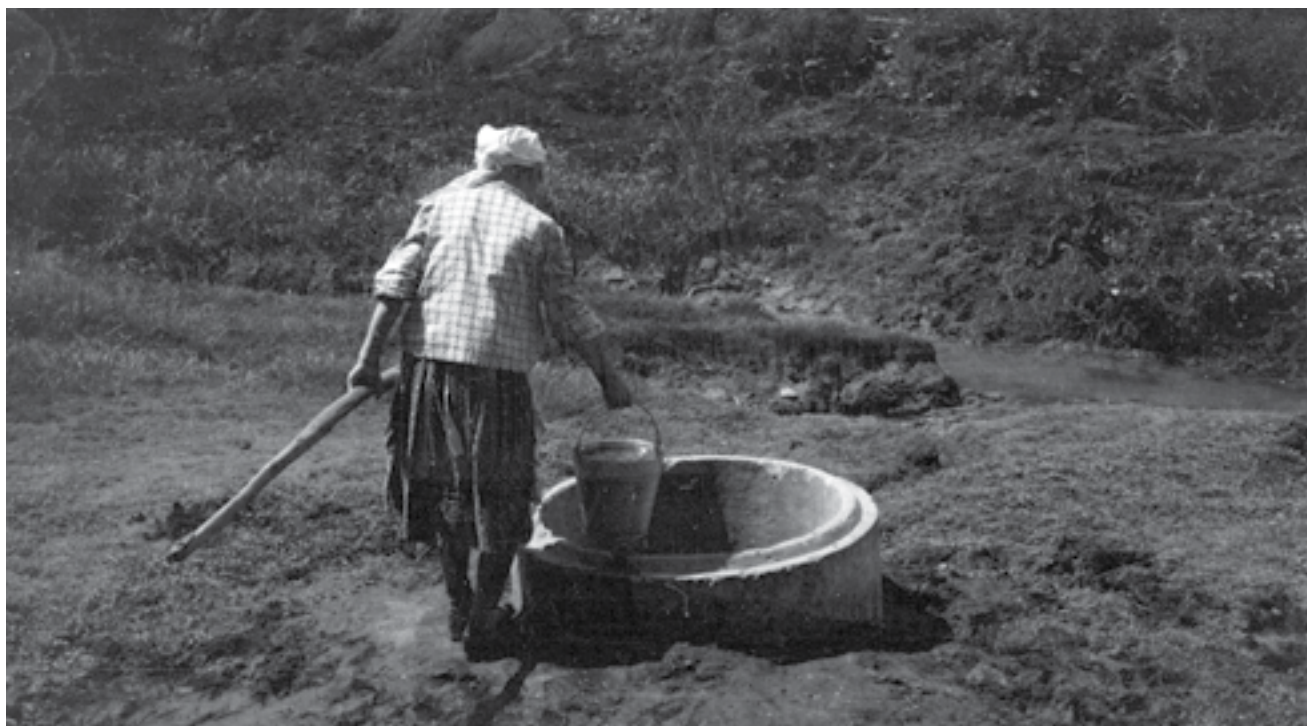
Колодец с цементным кольцом при неглубоком водоносном слое. Орловская область. Материалы О.А. Ганцкой. Фото В.В. Вентцеля, 1954 г.
