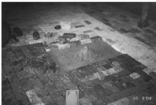
Фото 11. Финишный этап настилки кирпичного пола
