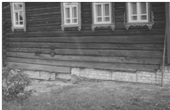
Фото 7. Пример частичного удаления сгнивших бревен
