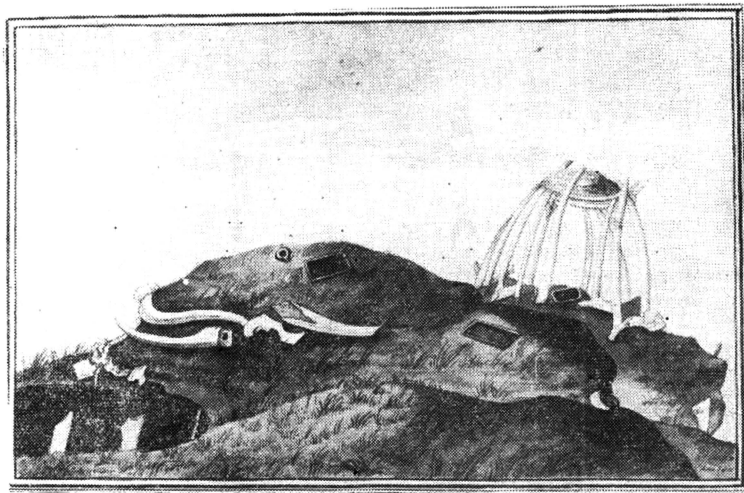
Рис. 6. Внешний вид зимнего подземного жилища оседлых чукчей, построенного из китовых костей.
